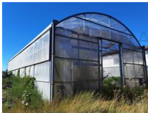
Foto 2 - Serra a tunnel N°1
