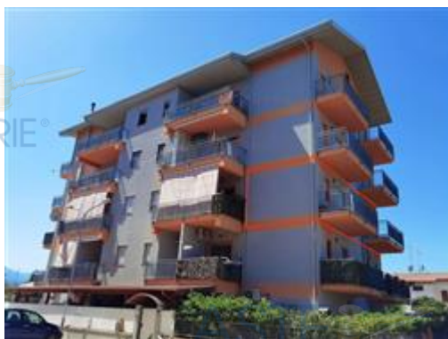
Foto 1 - Esterni con indicazione U.I.U. Lotto 1
