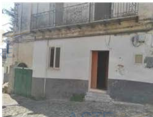
Ingresso da Via Interzati
