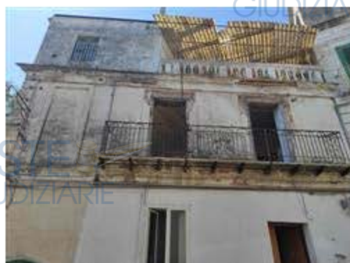
Particolare facciata Via Internati
