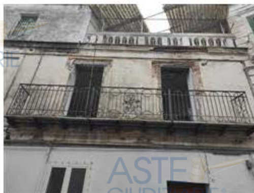
Particolare balcone aggettante su Via Interzati
