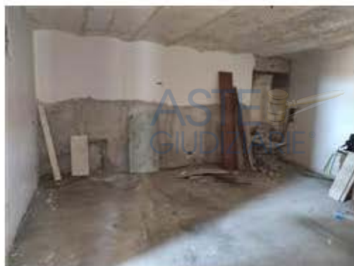
Interno vano principale
