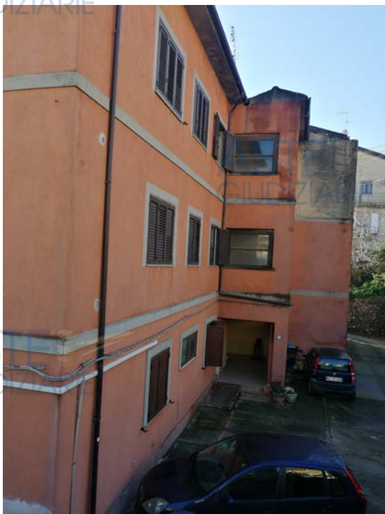
Piazzale di accesso
