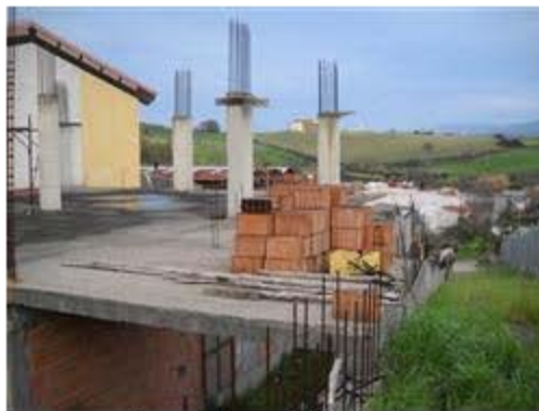
Porzione di mensola da demolire
