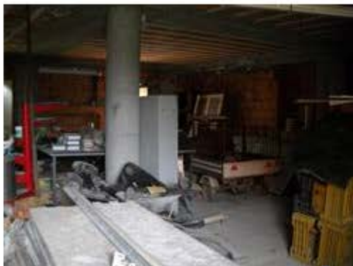
Interno del fabbricato
