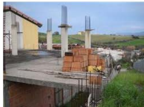
piano primo lastrico solare
