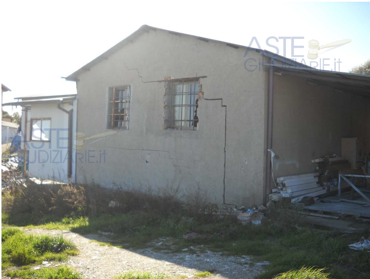
Il prospetto esterno con lesioni e cedimento della tompagnatura
