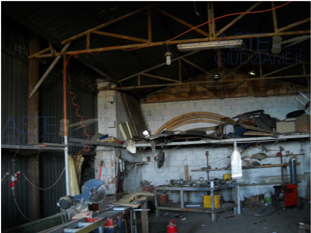
La struttura in acciaio (pilastrini – capriate – profilati)
