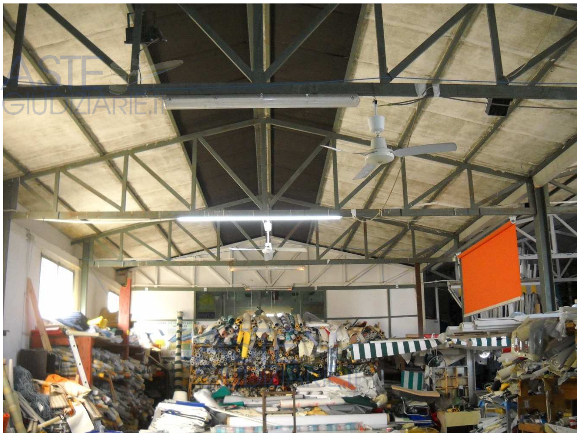
La struttura in acciaio (pilastri – capriate – profilati)
