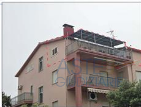
Vista esterna appartamento al P.3° lati Nord-Ovest e Sud-Ovest
