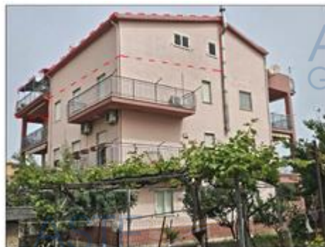
Vista generale fabbricato lati Sud-Ovest e Sud-Est
