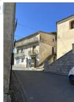
vista esterna fabbricato
