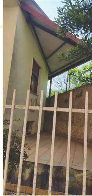
FOTO D'ESTERNO POSIZIONE SCATTO N. 5
