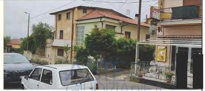
FOTO D'ESTERNO: POSIZIONE SCATTO N. 3
