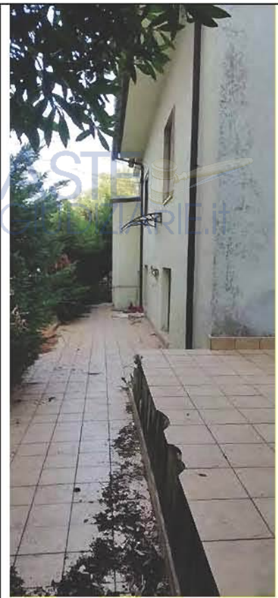
FOTO D'ESTERNO POSIZIONE SCATTO N. 9
