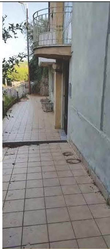
FOTO D'ESTERNO POSIZIONE SCATTO N. 8
