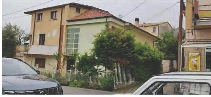
FOTO D'ESTERNO: POSIZIONE SCATTO N. 2
