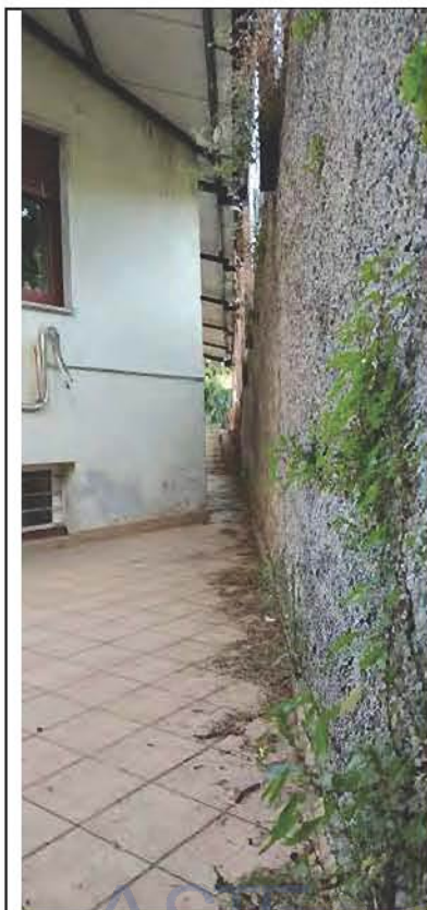
FOTO D'ESTERNO POSIZIONE SCATTO N. 10
