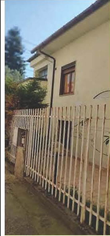
FOTO D'ESTERNO POSIZIONE SCATTO N. 6
