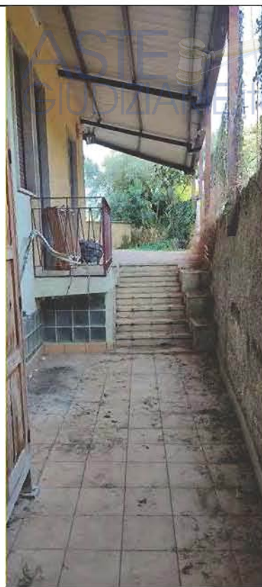
FOTO D'ESTERNO POSIZIONE SCATTO N. 11
