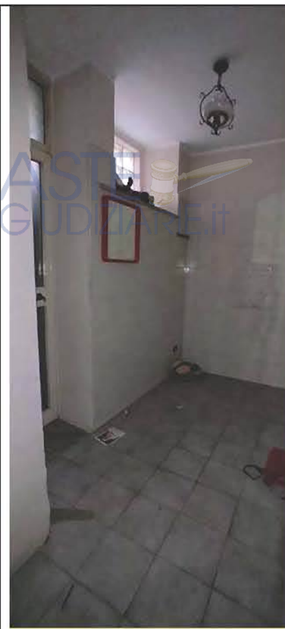
FOTO D'INTERNO: POSIZIONE SCATTO n.5
