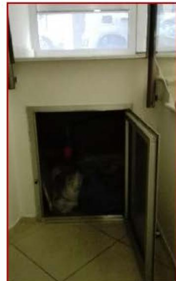
Foto n. 23 – vano ispezionabile scarichi e dettaglio pavimenti
