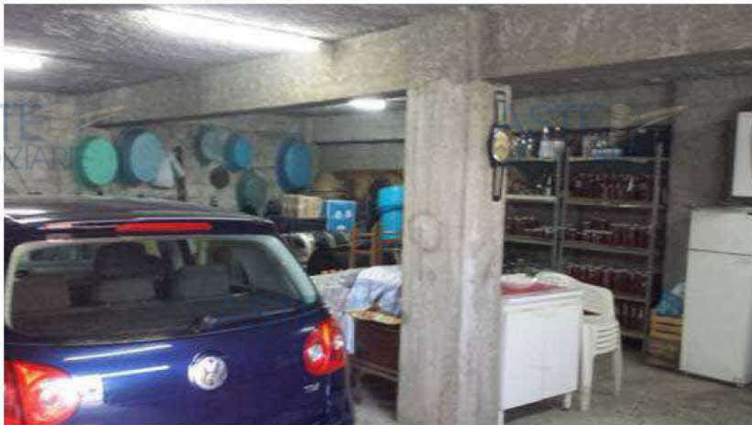
Figura 33 Magazzino Piano sotterraneo
