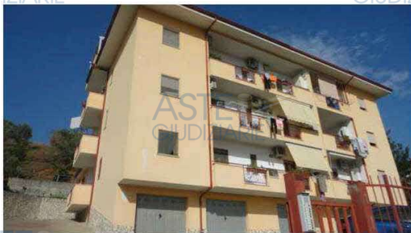
Figura 1 Prospetto frontale palazzina
