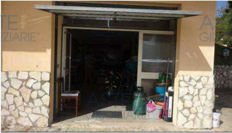
Figura 8 Ingresso garages dal prospetto frontale
