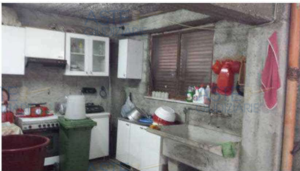
Figura 32 Magazzino Piano sotterraneo
