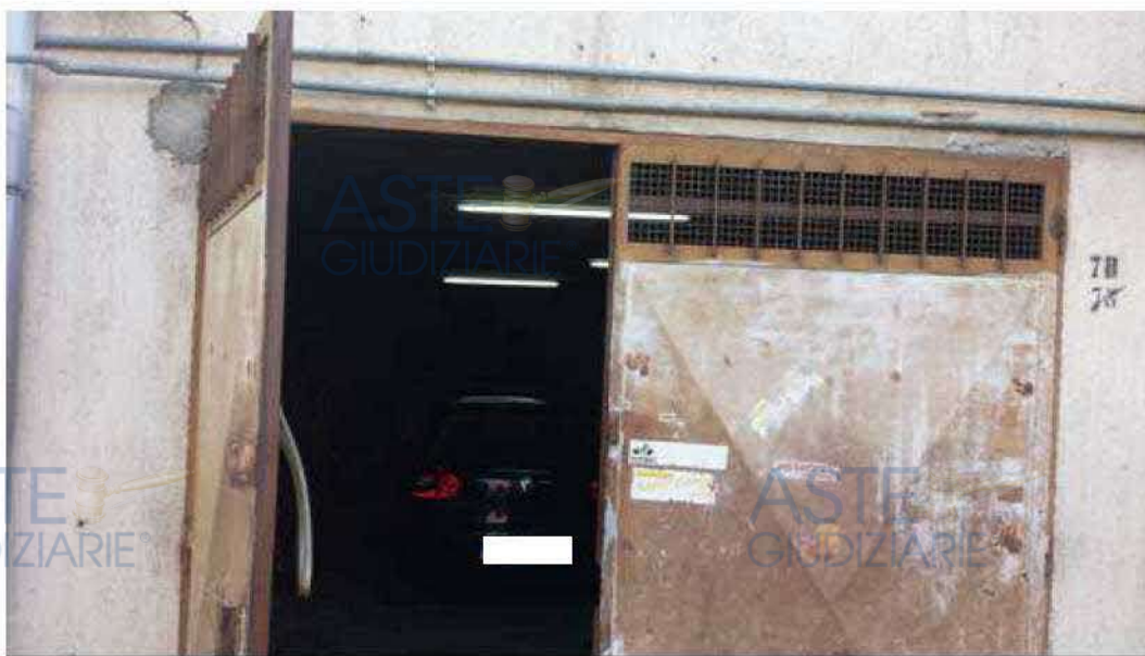
Figura 31 Magazzino Piano sotterraneo ingresso
