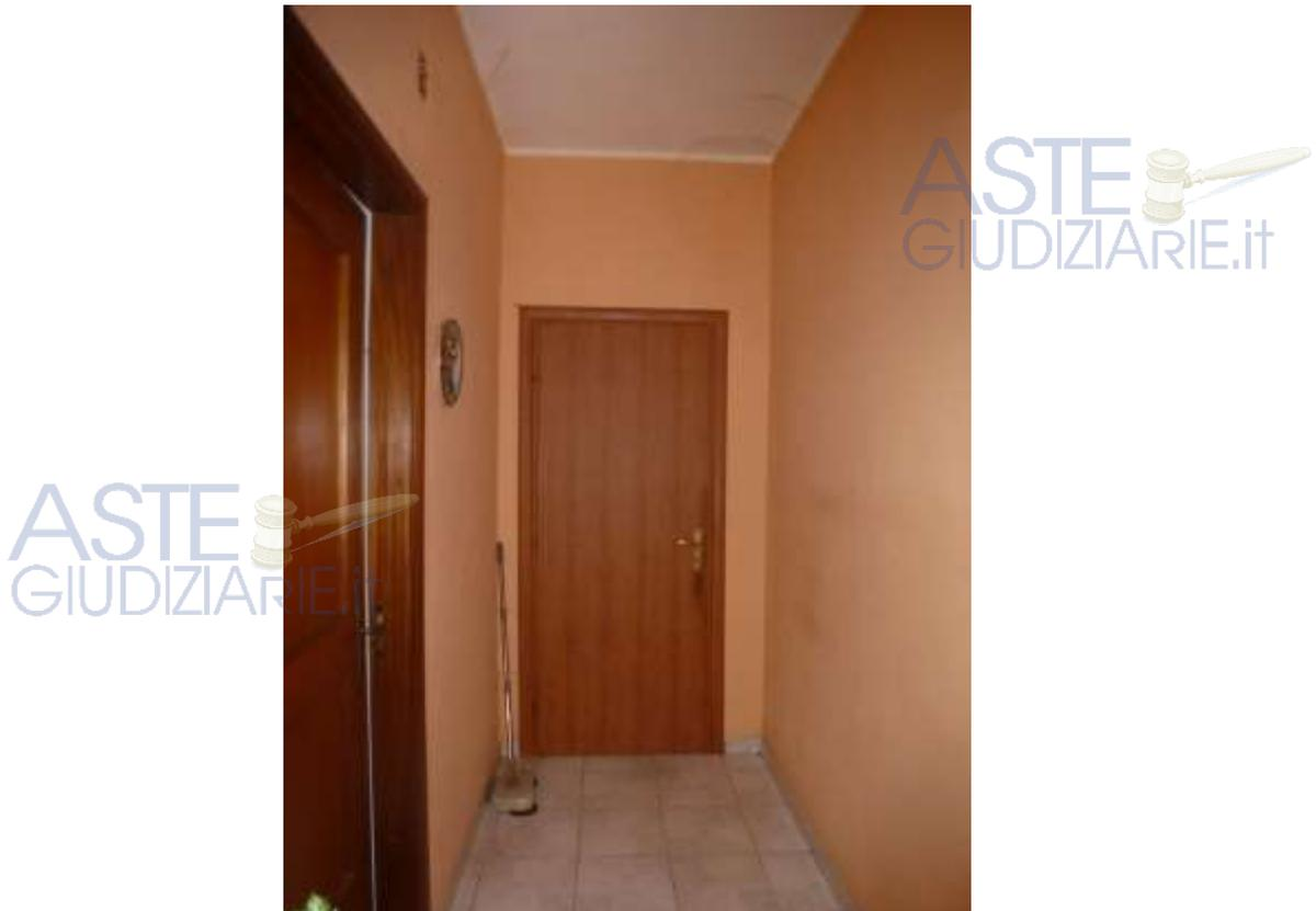
Foto n. 16 – Porta realizzata nel corridoio al posto della finestra prevista in progetto
