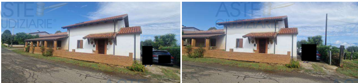
foto 1 e foto 2 – Vista prospettica fabbricato lato SUD
