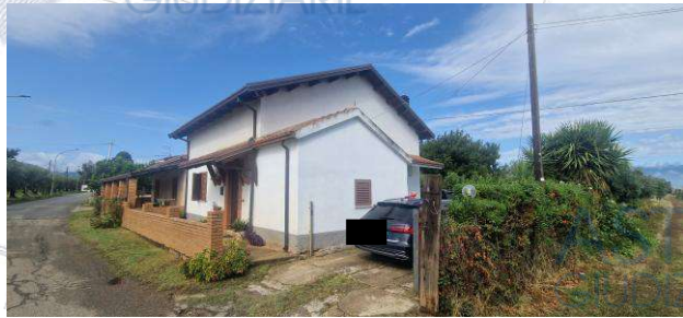
foto 2 – Vista prospettica fabbricato lato OVEST
