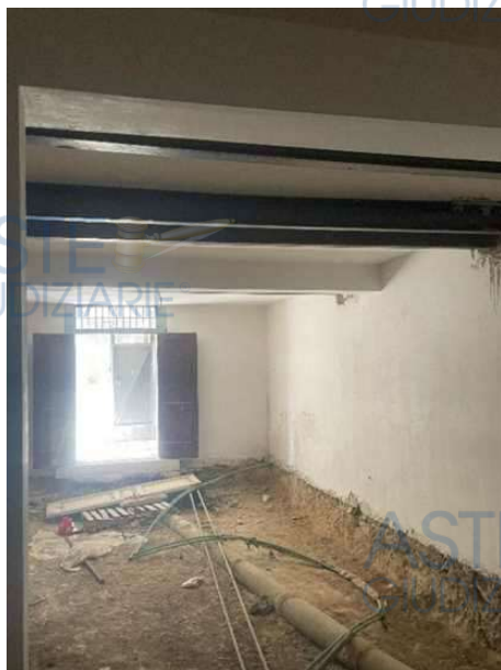
Figura 7 -Piano Terra_Locale di Sgombero
