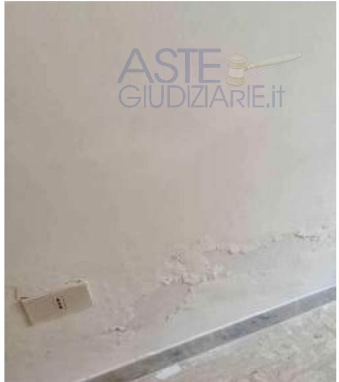
Fig.36 - 37) particolari delle tracce di umidità, infiltrazioni d'acqua
