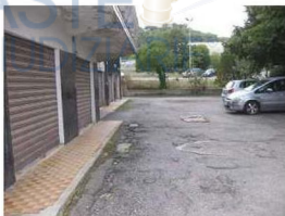
Fabbricato via G. Amendola, 23 – Castellibero (CS) – Area esterna
