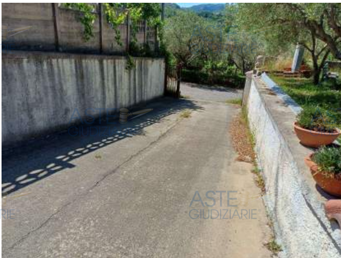
Foto N.6: Ingresso carrabile lato fabbricato Sud
