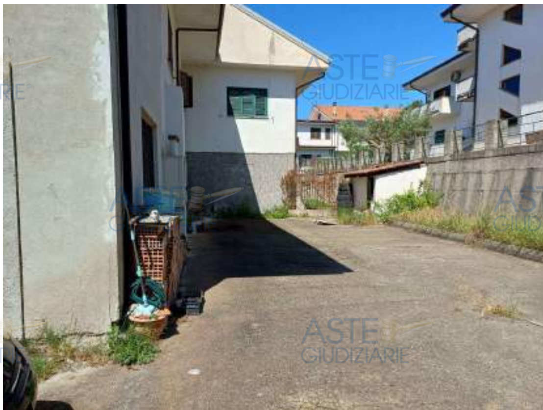
Foto N.2: Spazio esterno lato fabbricato Nord
