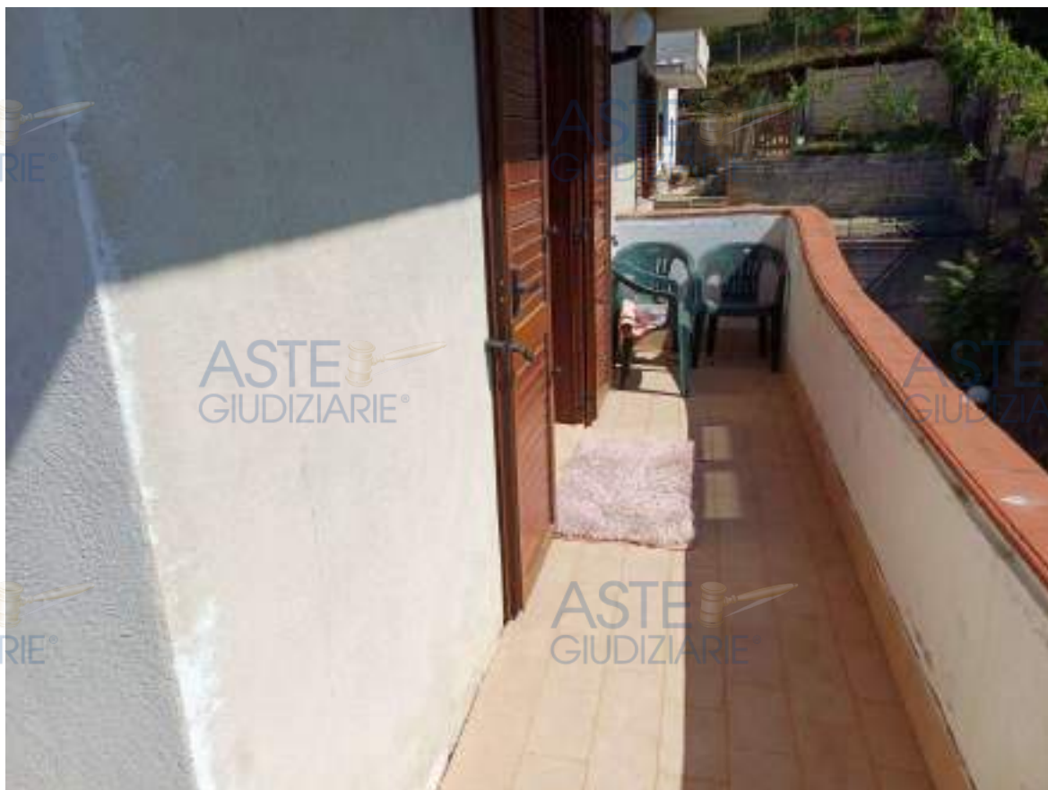
Foto N.12: Balcone lato Est
