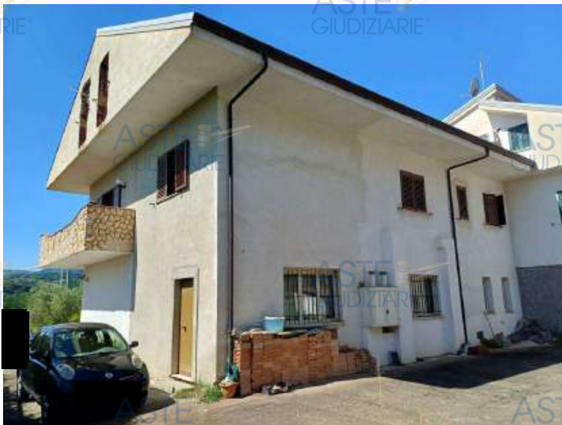
Foto N.1: Prospetto fabbricato Nord-Est
