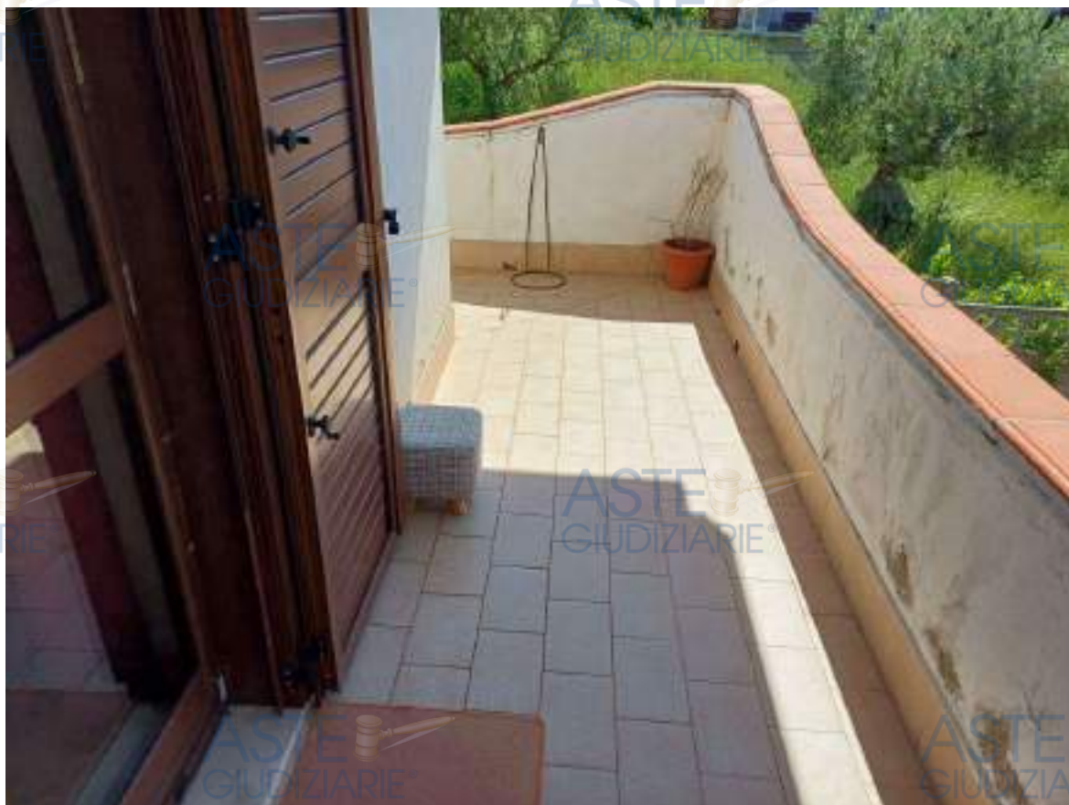
Foto N.11: Balcone lato Sud
