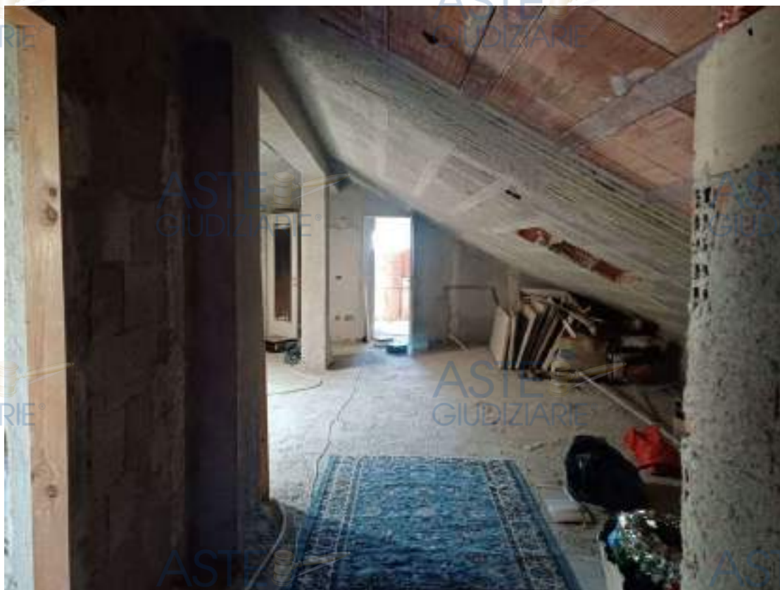
Foto N.32: Sottotetto al piano secondo al rustico
