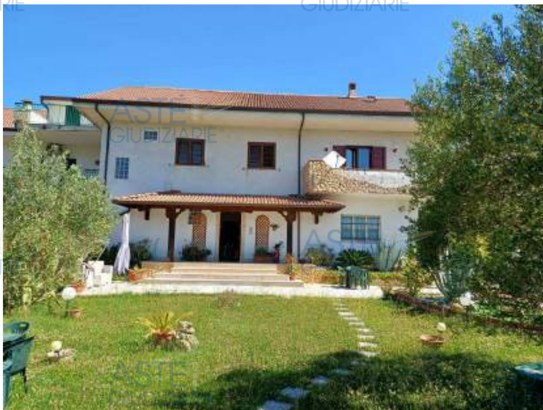
Foto N.3: Prospetto fabbricato Sud
