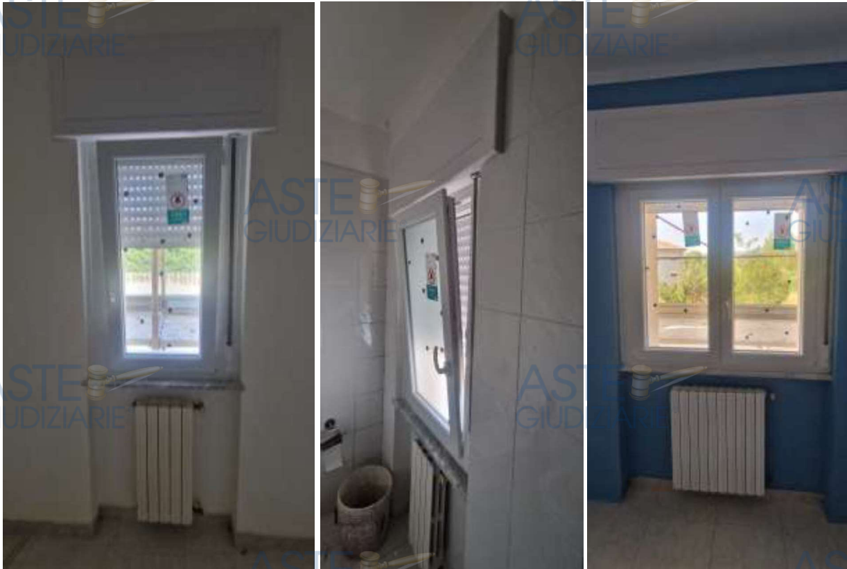
Nuovi infissi completi di cassonetti e avvolgibili
