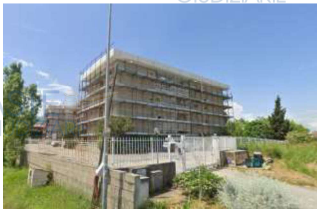
Vista prospettica fabbricato lato SUD – OVEST
