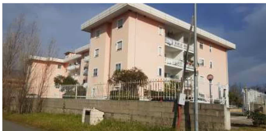
Vista prospettica fabbricato lato SUD - OVEST
