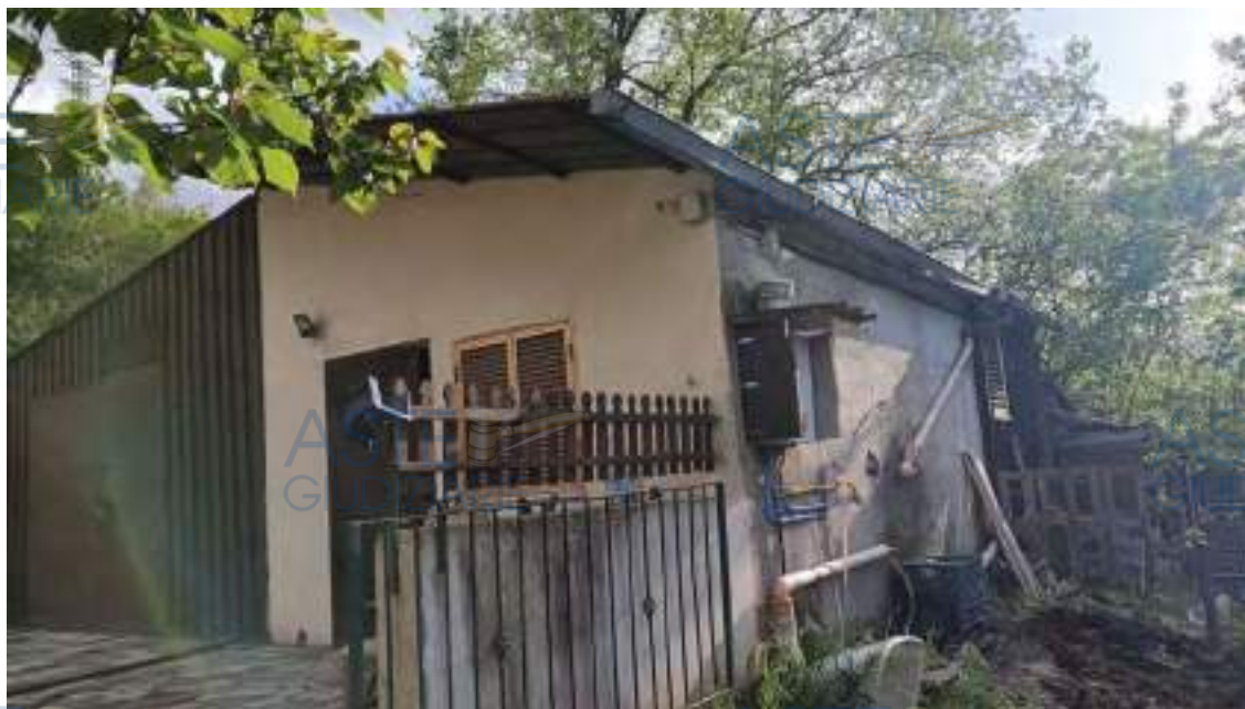
Foto n° 32 - Vista esterna manufatti in muratura e carpenteria metallica
