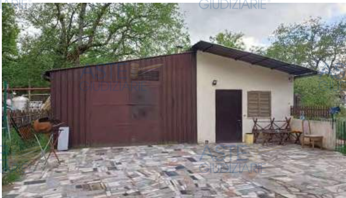
Foto n° 31 - Vista esterna manufatti in muratura e carpenteria metallica
