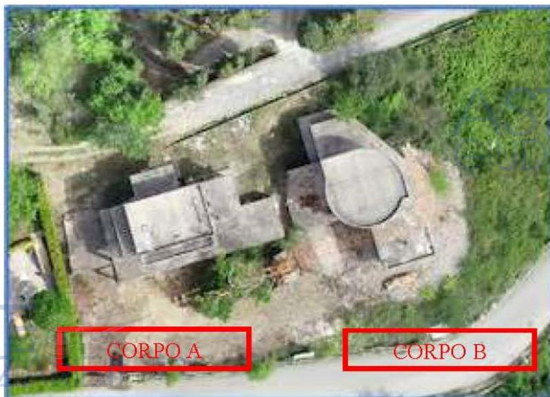
L'immagine riportata scaturisce dall'inquadramento dell'area effettuato con il drone utilizzato per le operazioni di rilievo; come evidente, due fabbricati presentano la tipologia di ville unifamiliari, allo stato realizzate per la sola parte strutturale, con telai a travi e pilastri in c.a., solai latero-cementizi e solette di copertura in c.a.; per il primo livello in entrambi i fabbricati anche parte della muratura perimetrale è in c.a.
