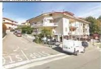
Vista dello stabile da via Morroni Innoce[n]za – fronte OVEST
