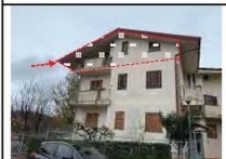
Vista dell'immobile dalla corte interna – fronte NORD
