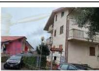
Vista dell'immobile dalla corte interna – fronte NORD
