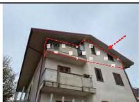
Vista dell'immobile dalla corte interna – fronte NORD
