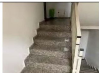
Vista della scala interna di accesso piano primo
