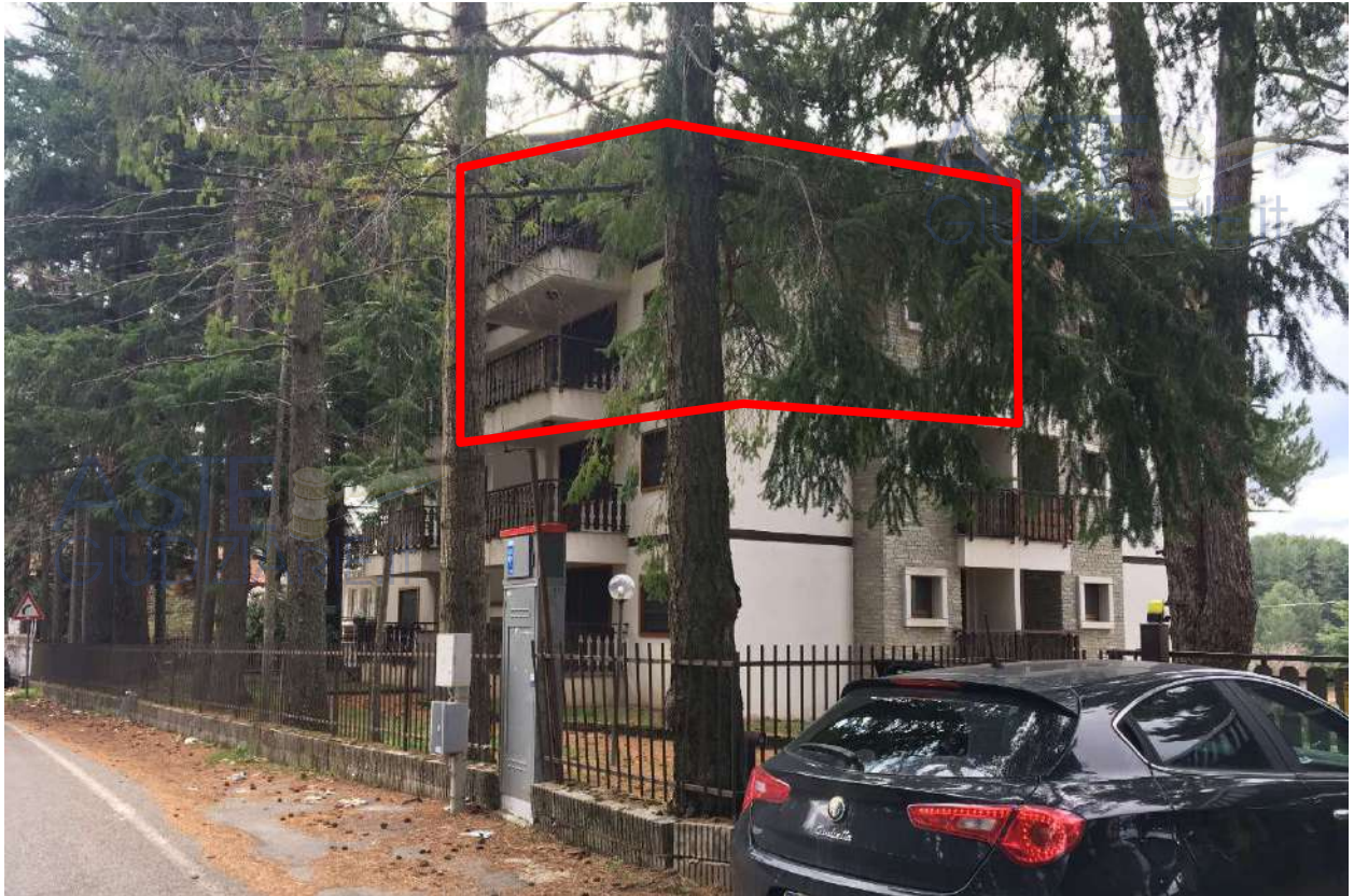
Figura 2: Individuazione immobile pignorato – vista lato nord-est .
