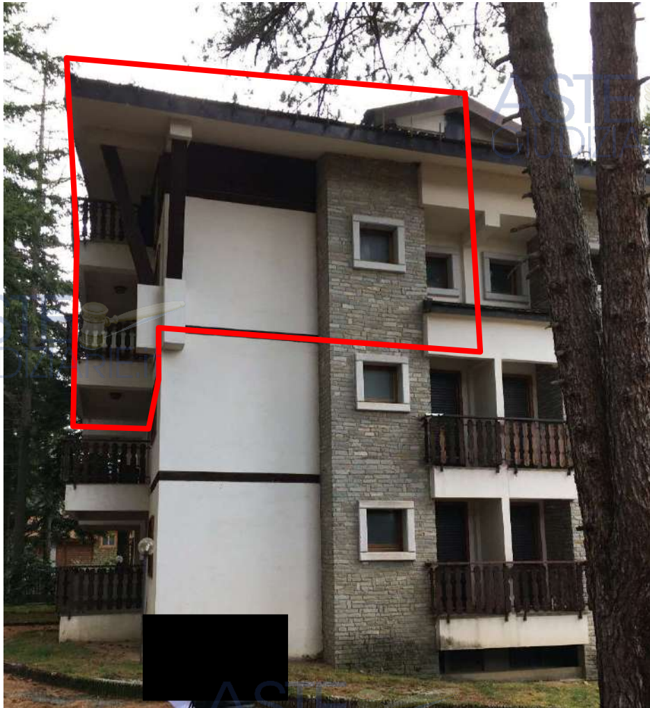
Figura 3: Individuazione immobile pignorato – vista lato nord .
