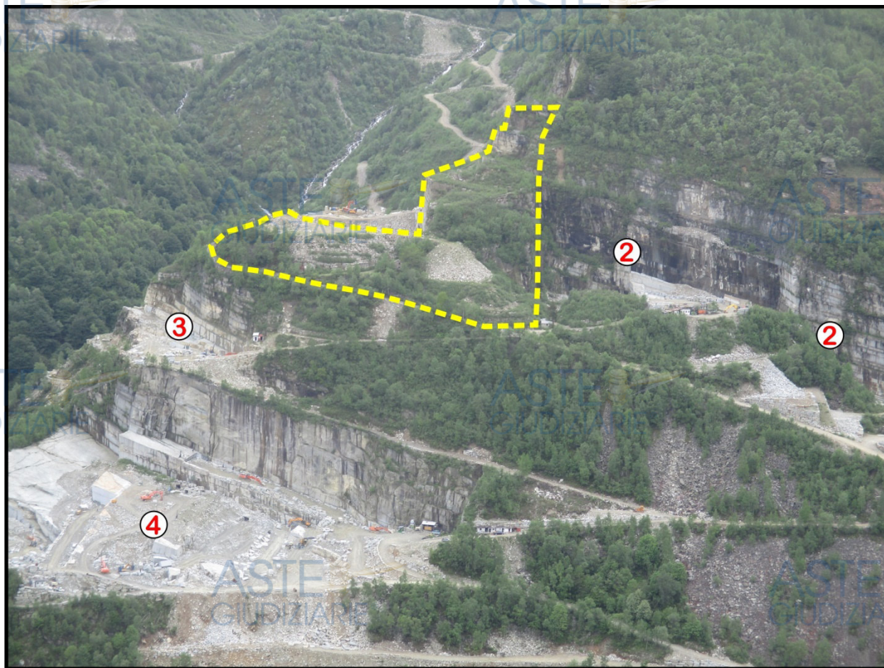
FOTO 3 (19/05/2020): Vista, dal Polo estrattivo di Rorà superiore, delle cave in oggetto (contorno giallo).
