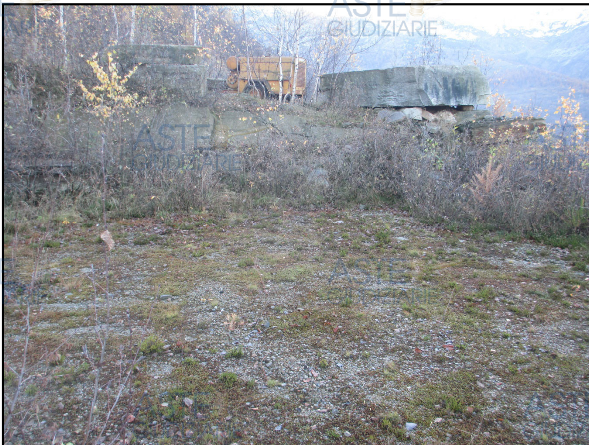
FOTO 14: Cava “Ciafalco – Lotti 17-18-19” - Piazzale di estrazione del cantiere intermedio colonizzato da presenza sparsa di Alnus Viridis .
