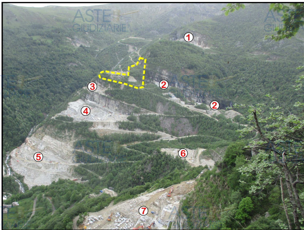
FOTO 2 (19/05/2020): Vista, dal Polo estrattivo di Rorà superiore, delle cave in oggetto (contorno giallo).
