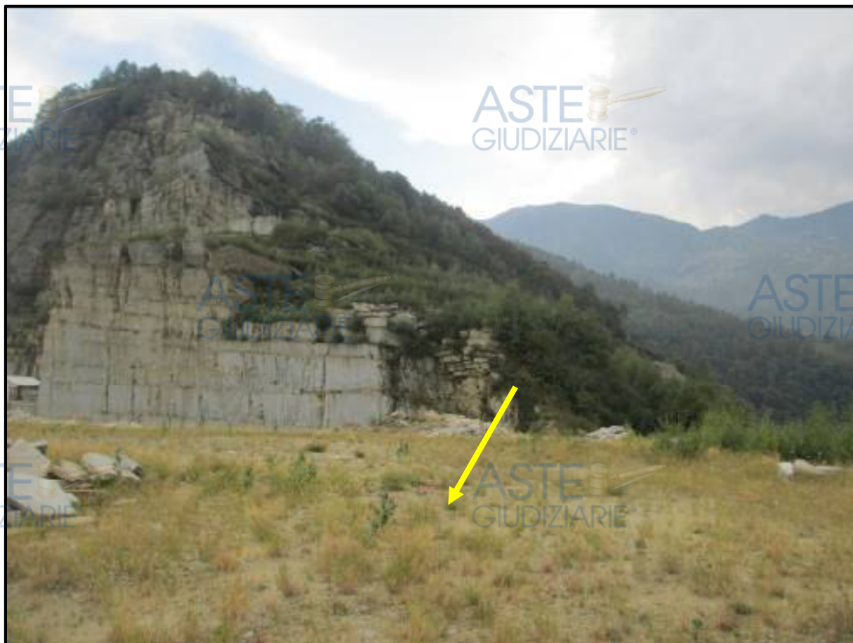
FOTO 17 (16/09/2020): Cava “Ciafalco – Lotti n. 20-21 e 2 fuori corso” - Piazzale in fase iniziale di recupero spontaneo mediante colonizzazione da parte di specie erbacee ed arboree.
