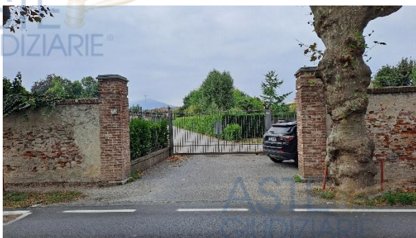
Ingresso Carraio e pedonale
