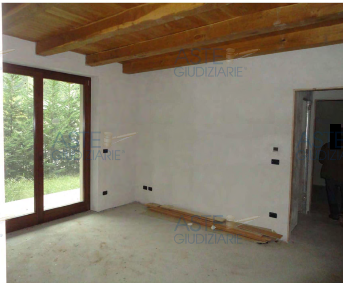
Residenza Argentera – interno alloggi
