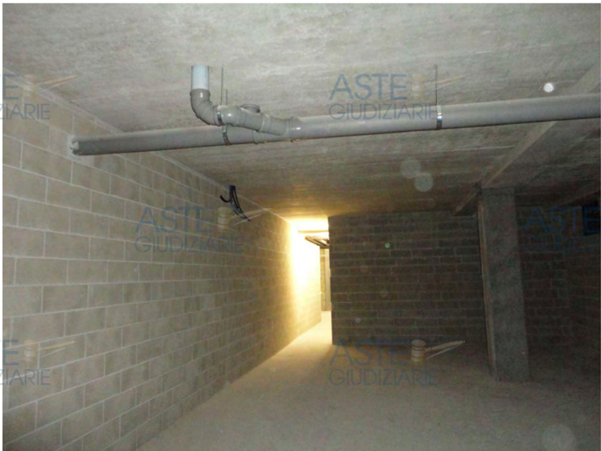
Residenza Belvedere – interno magazzino
