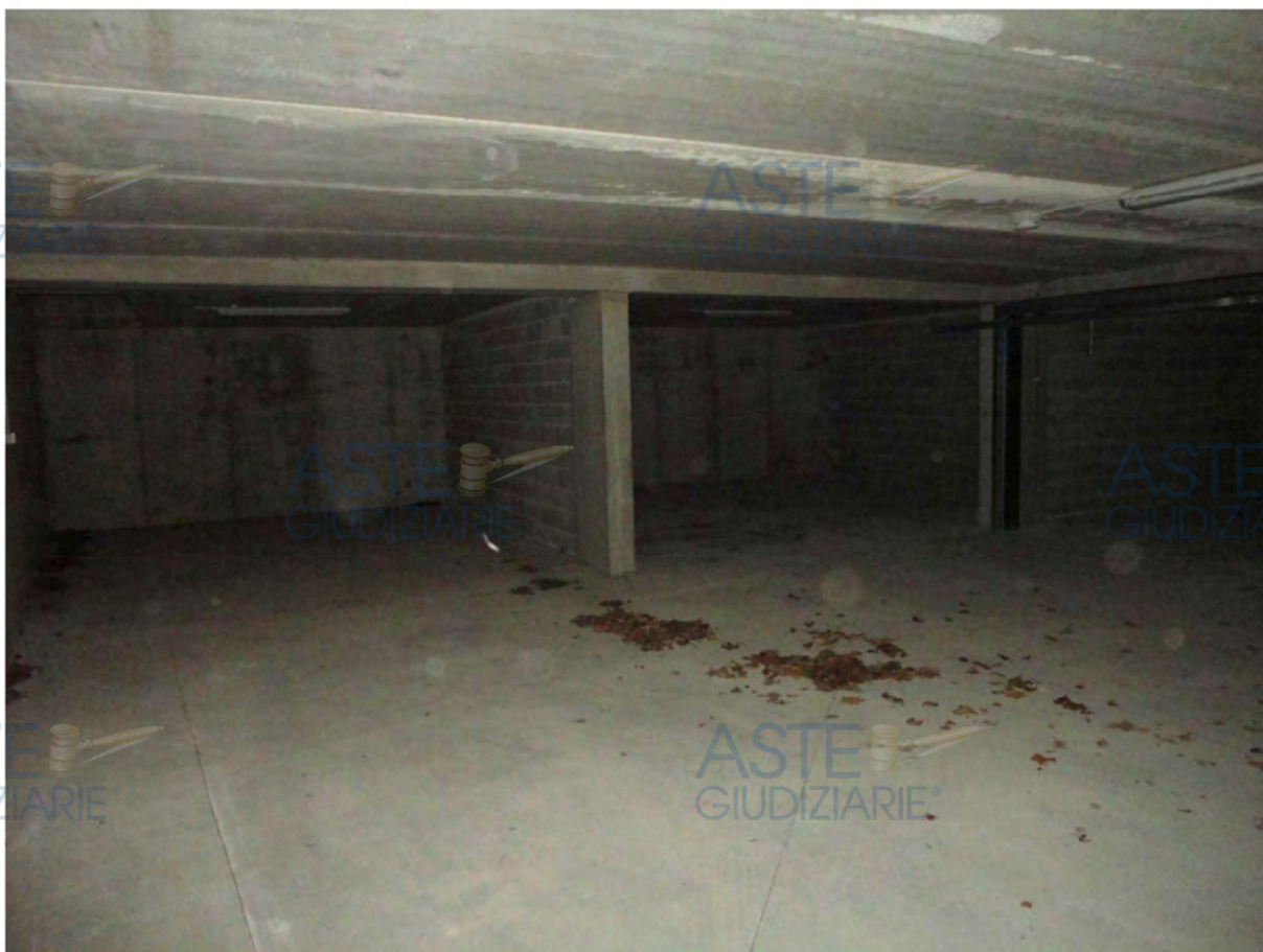
Residenza Argentera – Autorimessa
