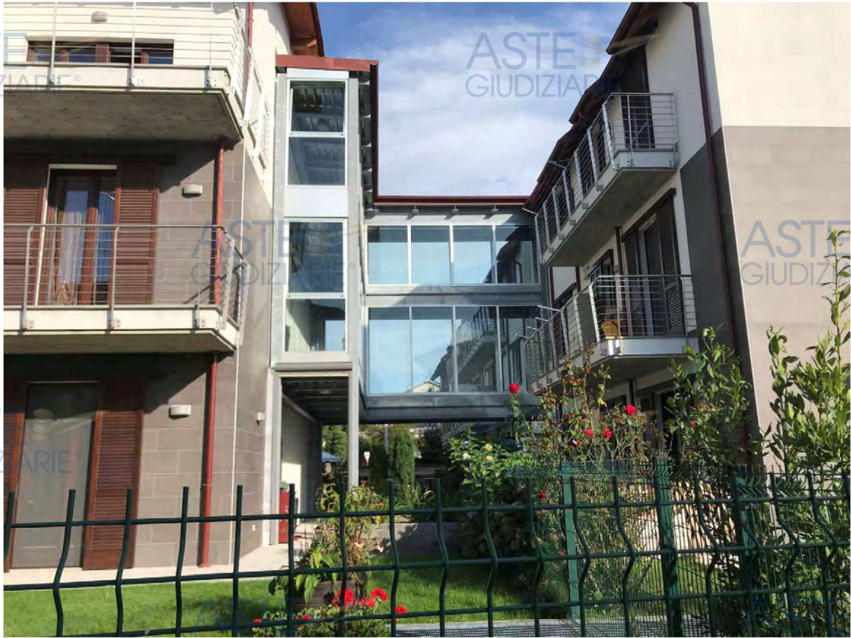
Residenza Maneggio - esterno
