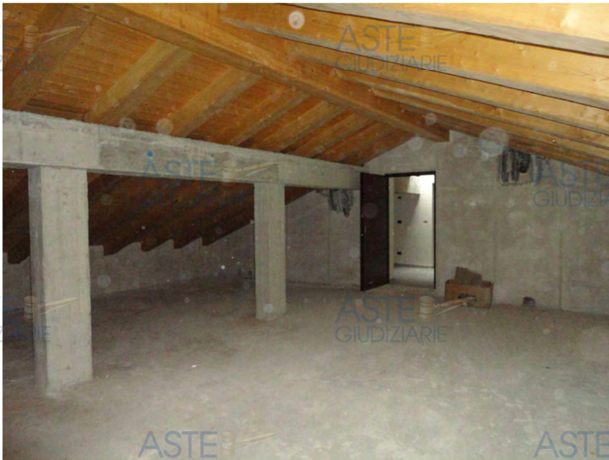
Residenza Argentera – interno sottotetto
