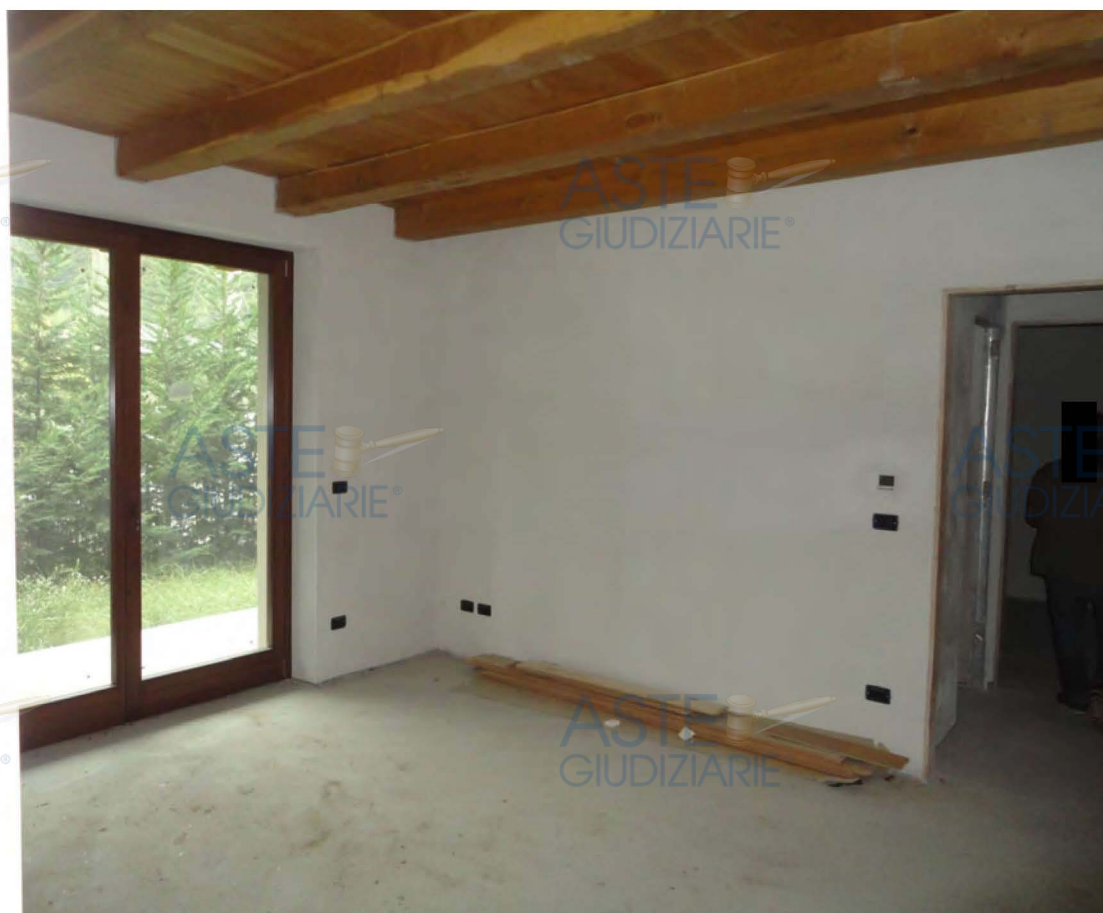
Residenza Argentera – interno alloggi
