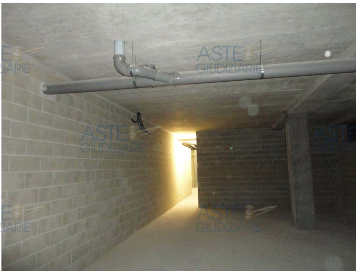
Residenza Belvedere – interno magazzino
