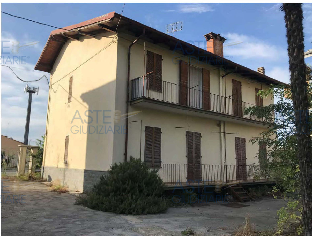
Fabbricato esistente per il quale è ammessa la demolizione
