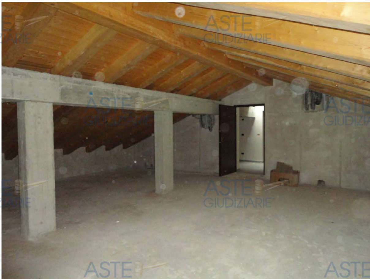
Residenza Argentera – interno sottotetto
