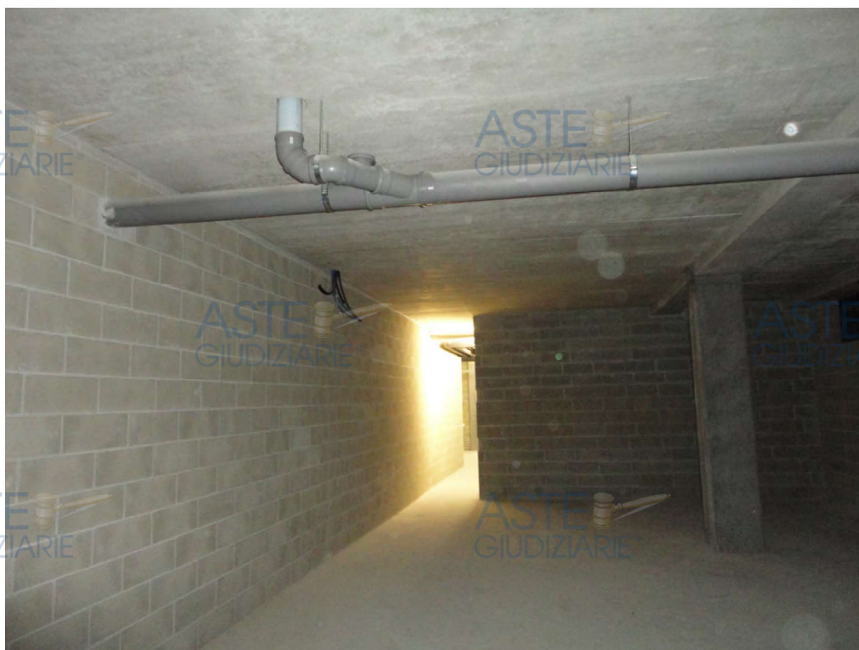
Residenza Belvedere – interno magazzino
