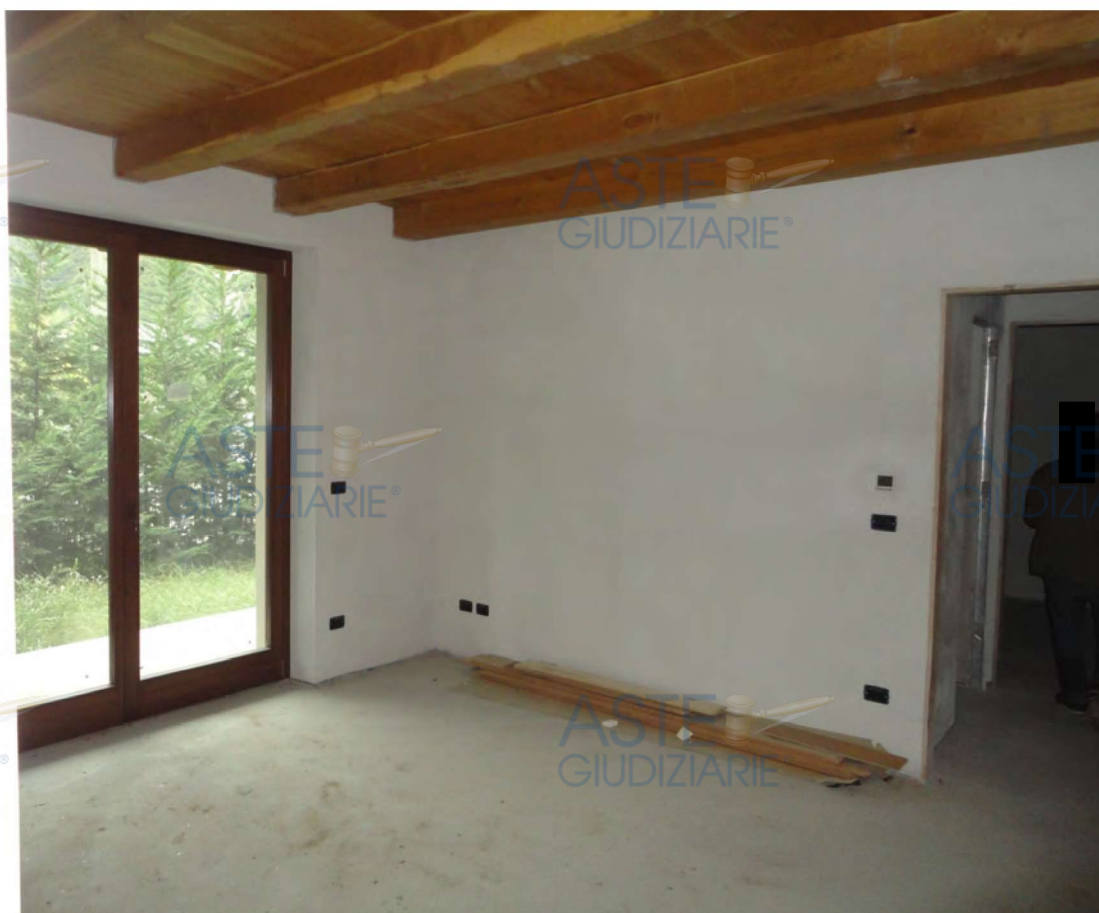
Residenza Argentera – interno alloggi
