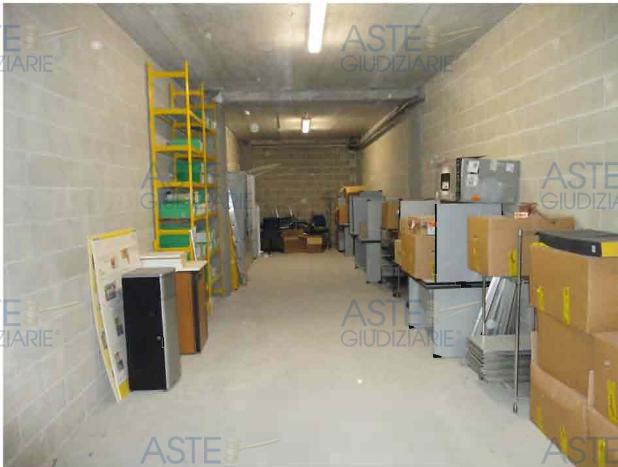
Residenza Belvedere – interno box auto
