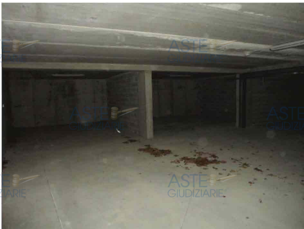
Residenza Argentera – Autorimessa
