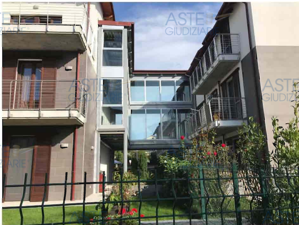
Residenza Maneggio - esterno
