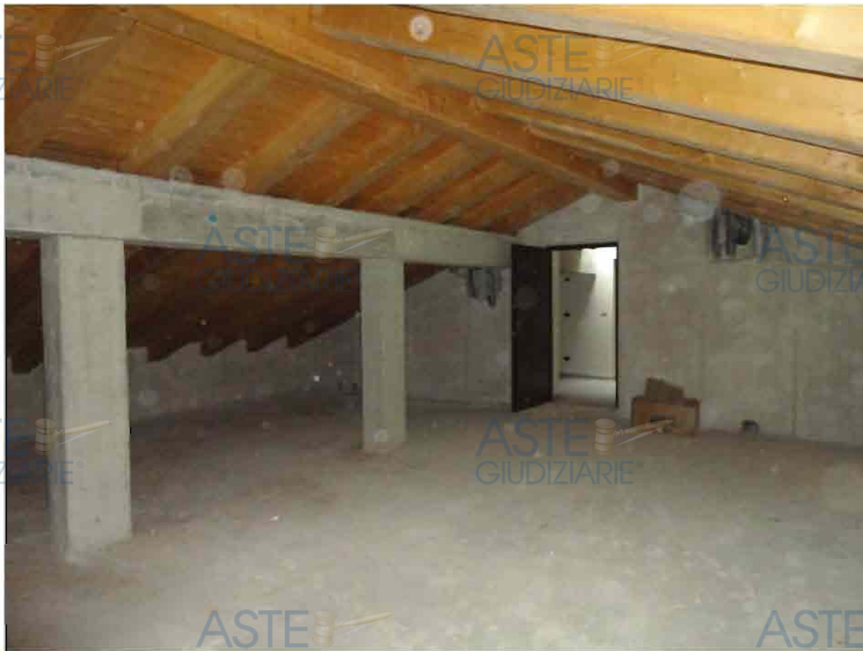
Residenza Argentera – interno sottotetto
