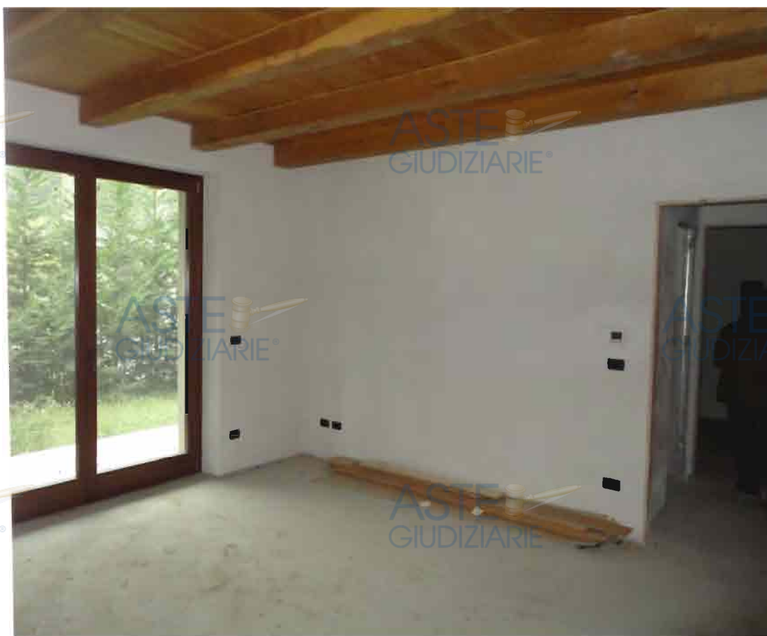
Residenza Argentera – interno alloggi
