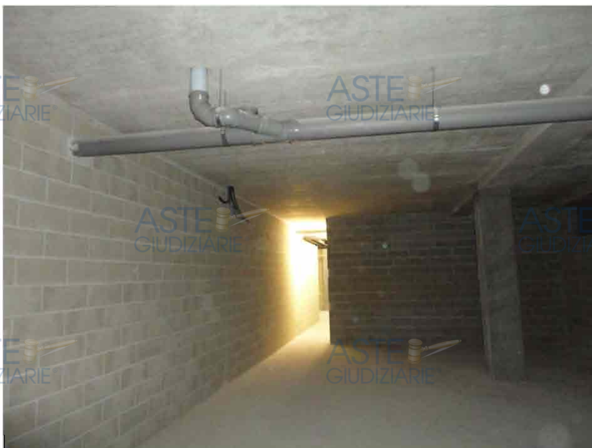
Residenza Belvedere – interno magazzino
