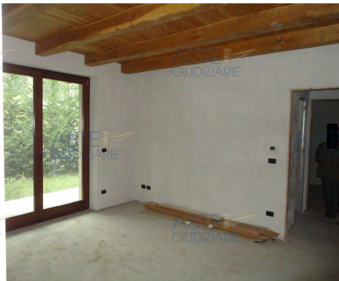
Residenza Argentera – interno alloggi
