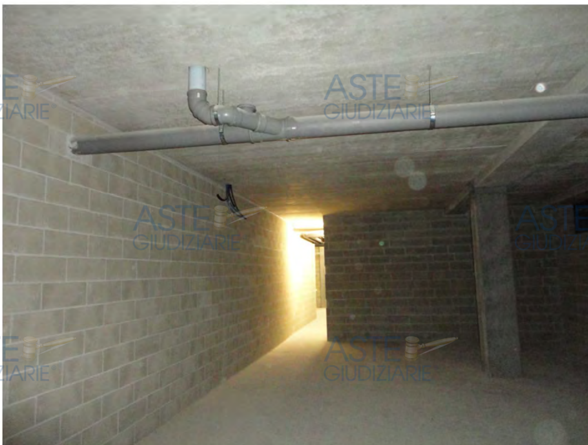
Residenza Belvedere – interno magazzino
