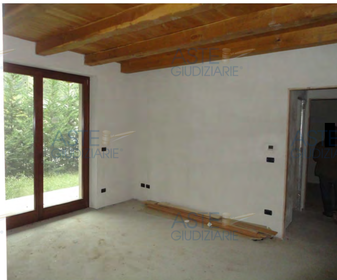
Residenza Argentera – interno alloggi
