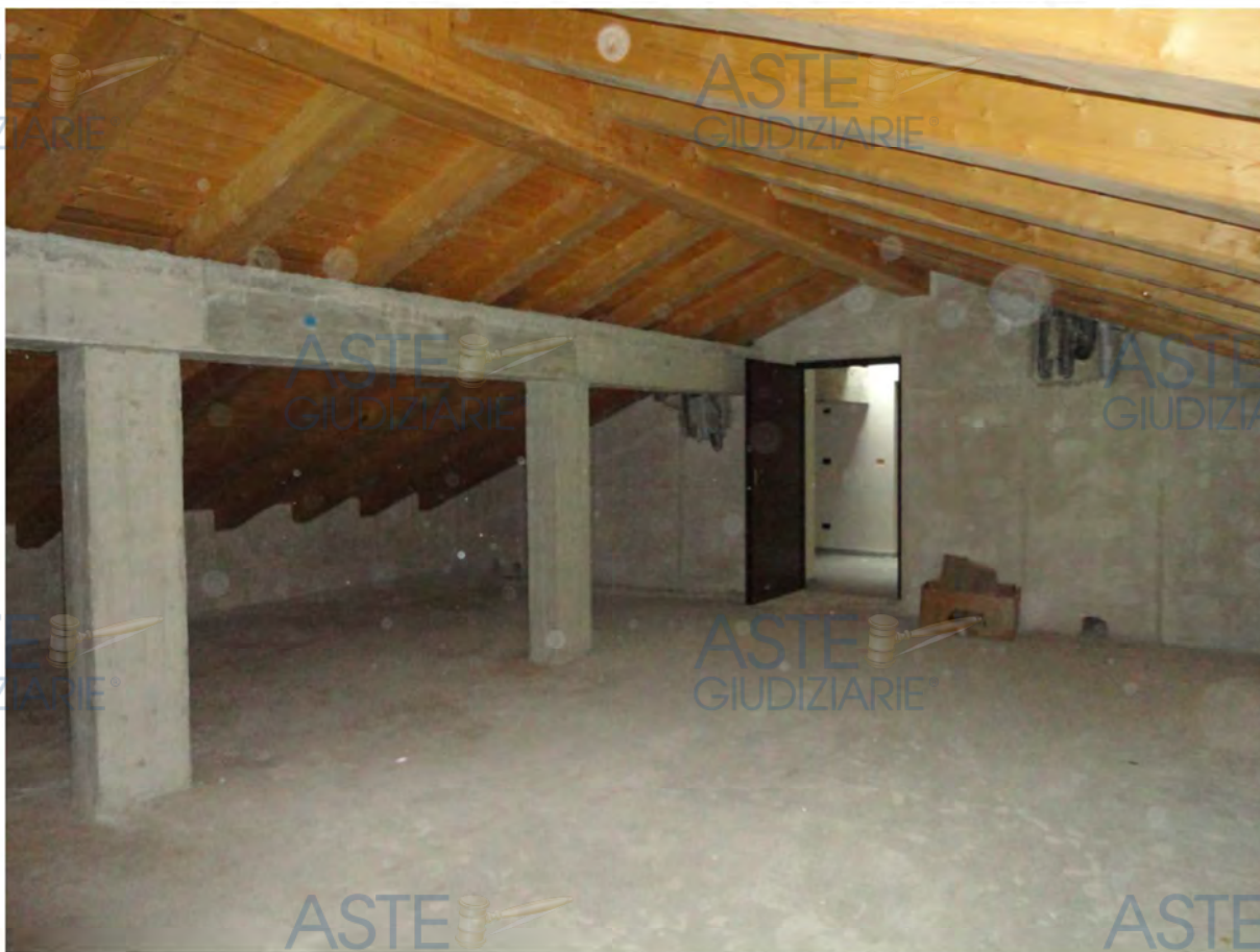
Residenza Argentera – interno sottotetto
