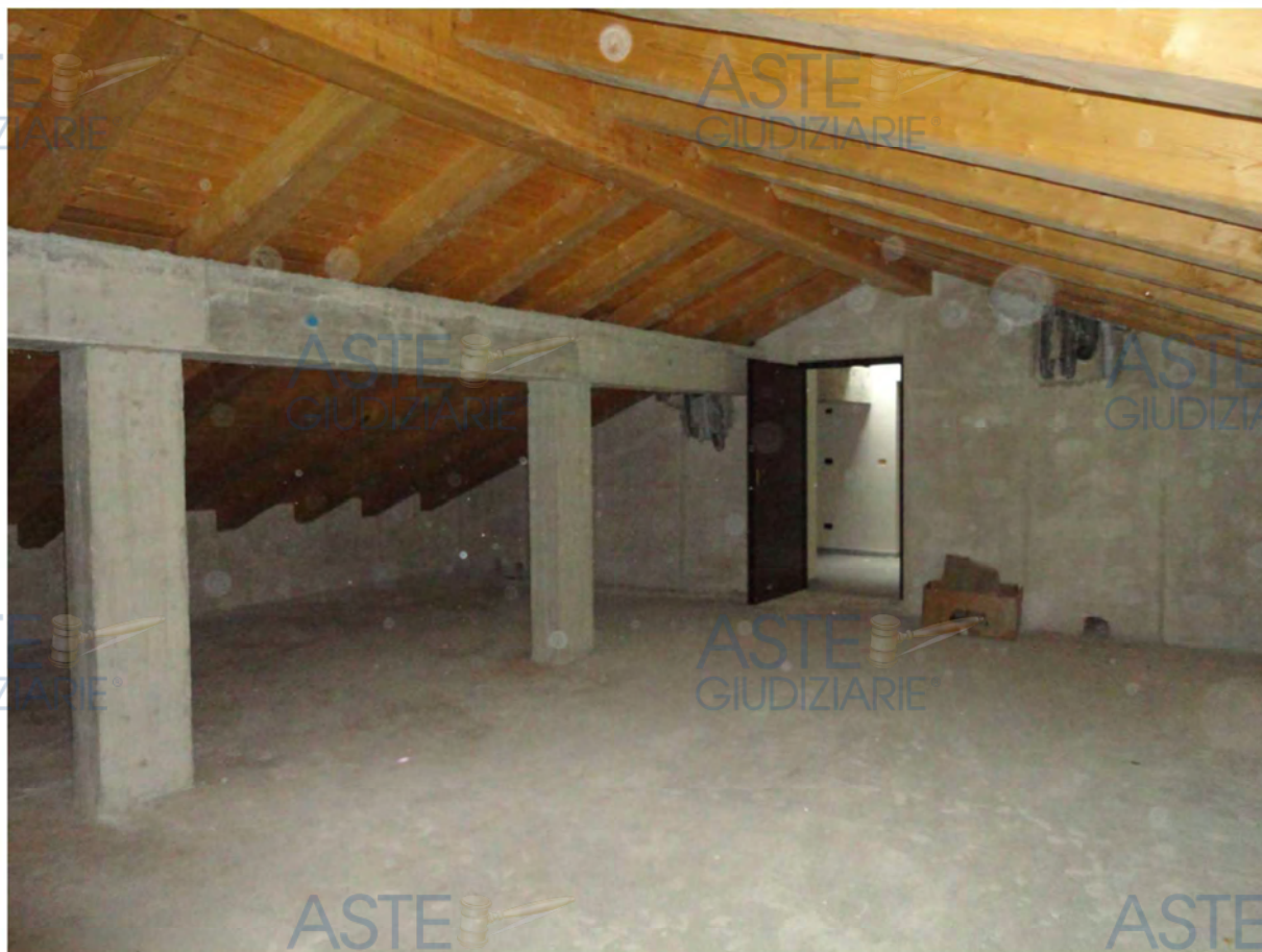
Residenza Argentera – interno sottotetto
