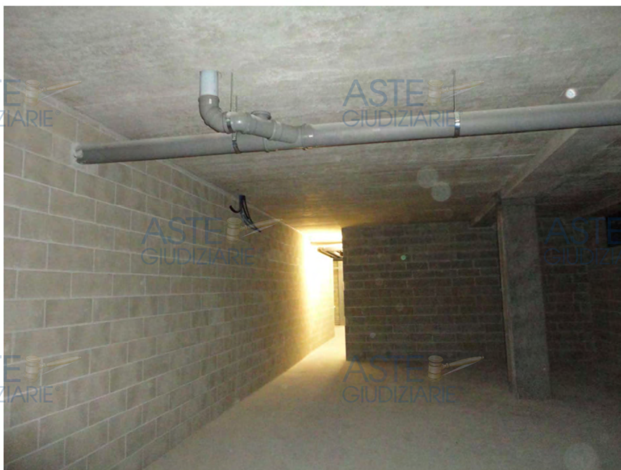
Residenza Belvedere – interno magazzino
