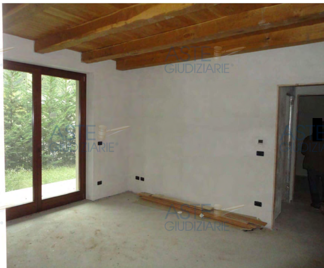
Residenza Argentera – interno alloggi
