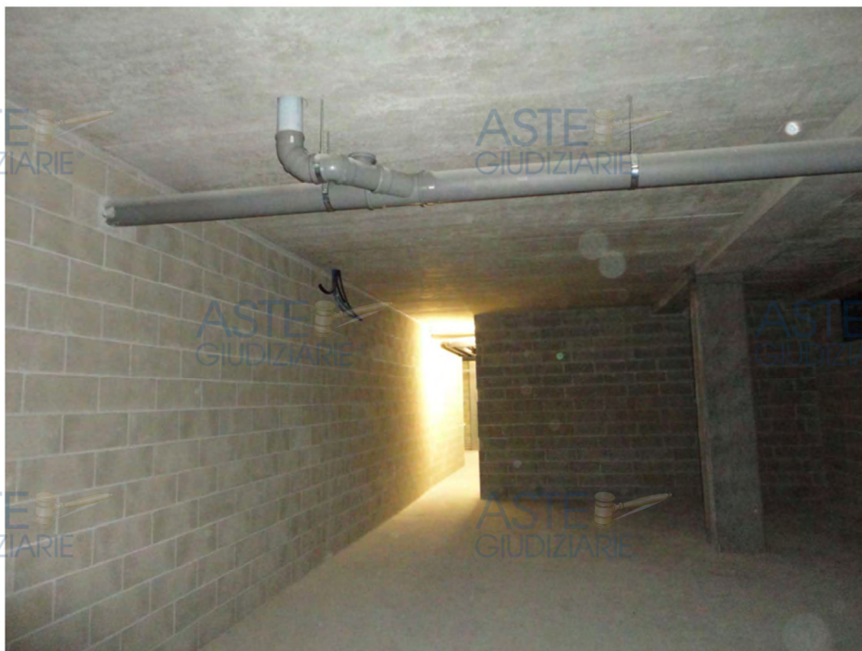
Residenza Belvedere – interno magazzino
