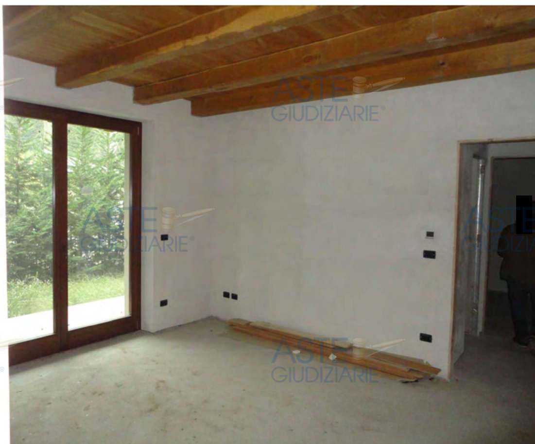
Residenza Argentera – interno alloggi
