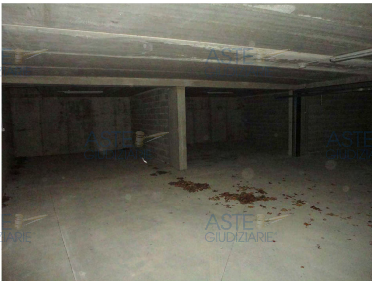
Residenza Argentera – Autorimessa
