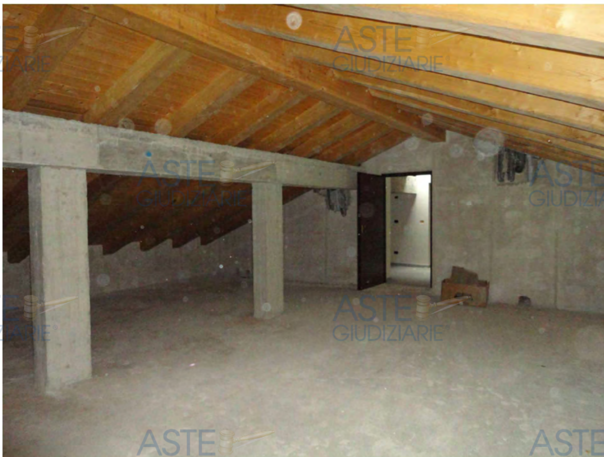
Residenza Argentera – interno sottotetto
