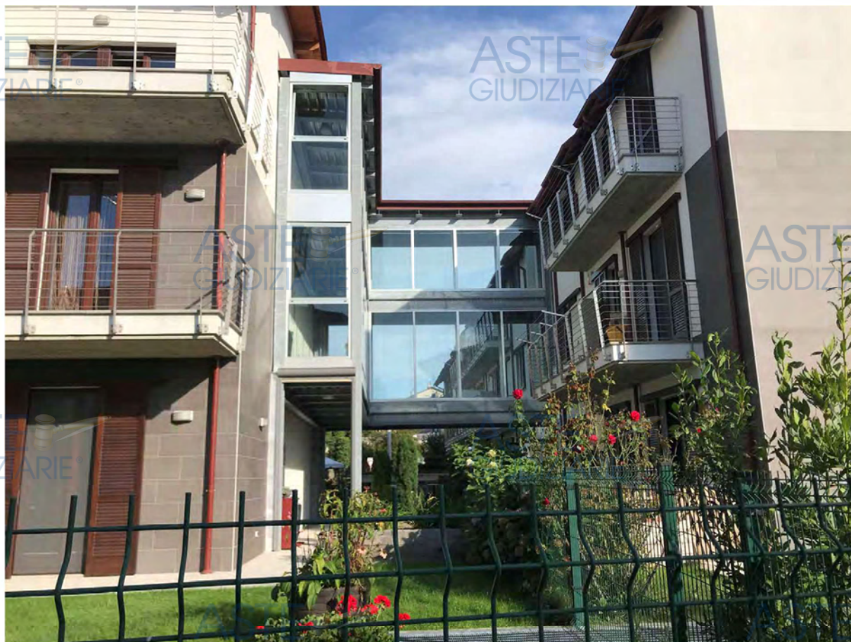
Residenza Maneggio - esterno
