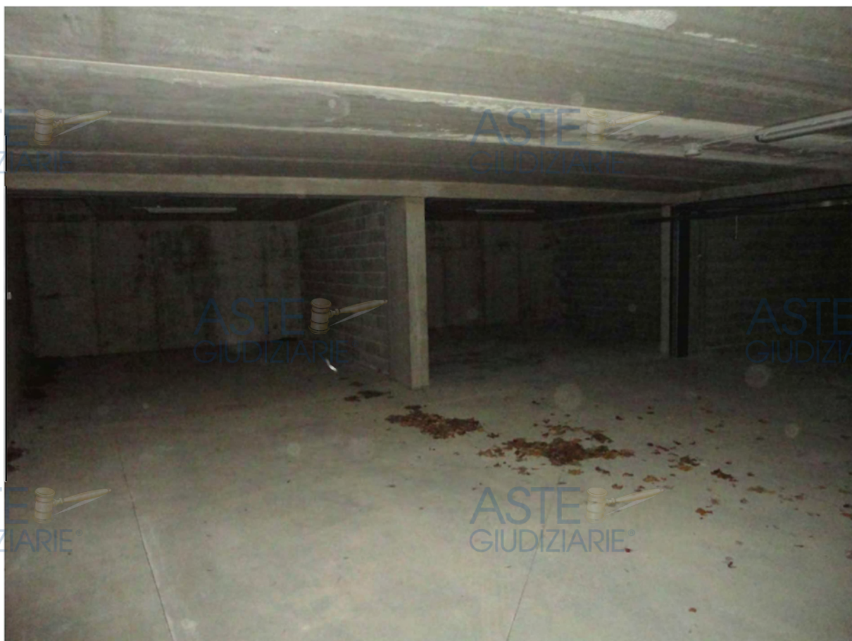
Residenza Argentera – Autorimessa
