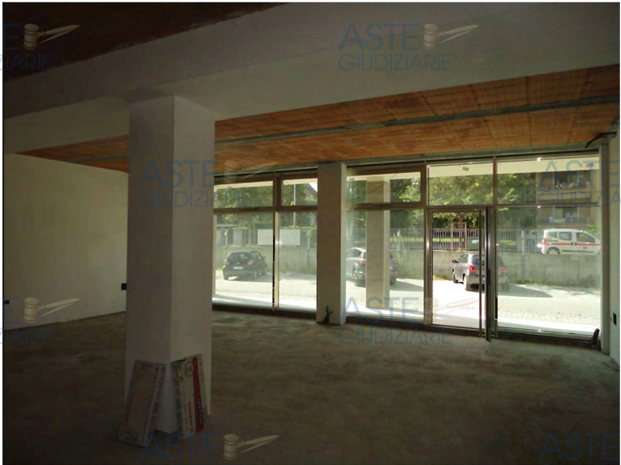
Residenza Belvedere – interno negozio
