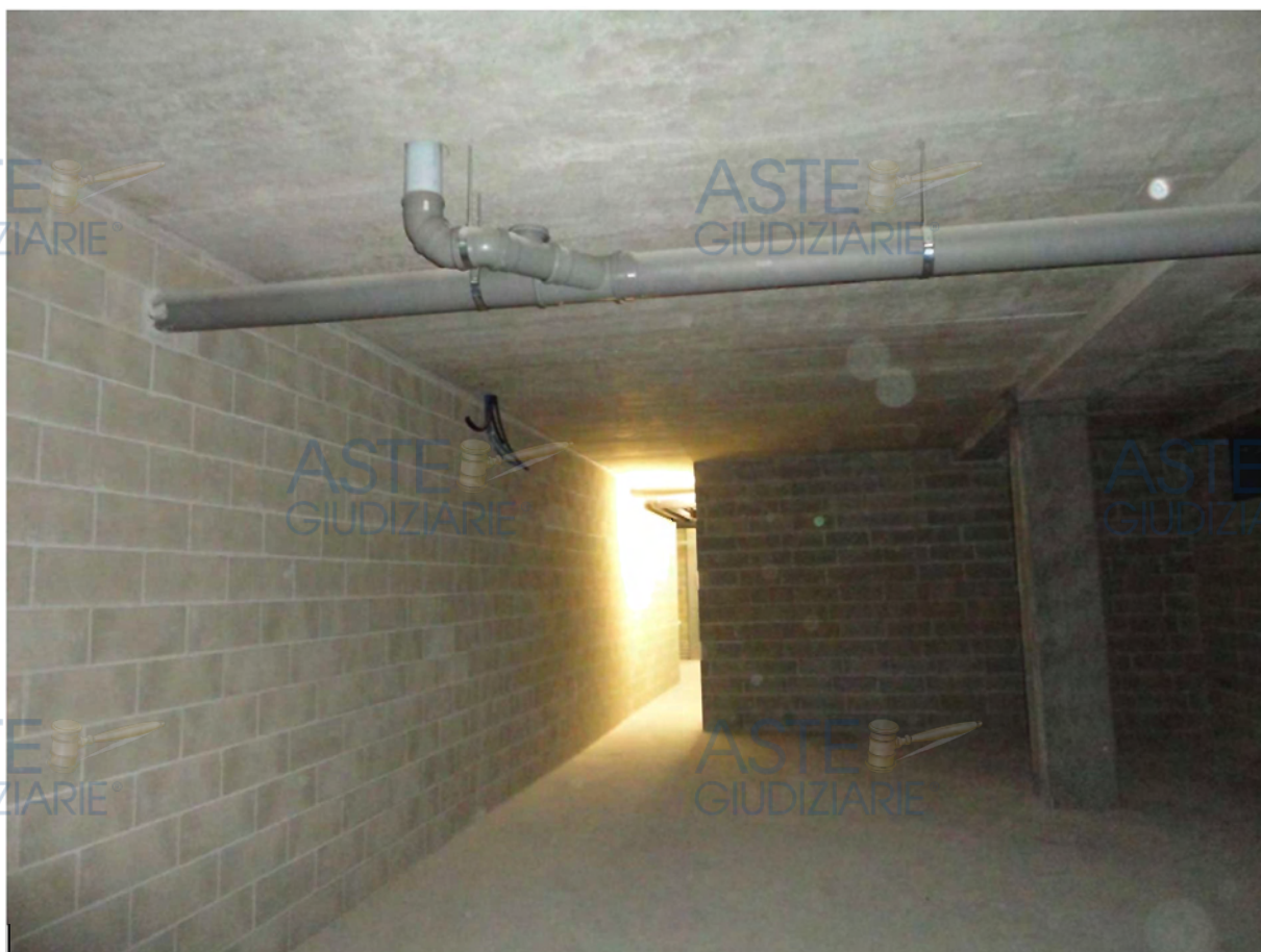
Residenza Belvedere – interno magazzino
