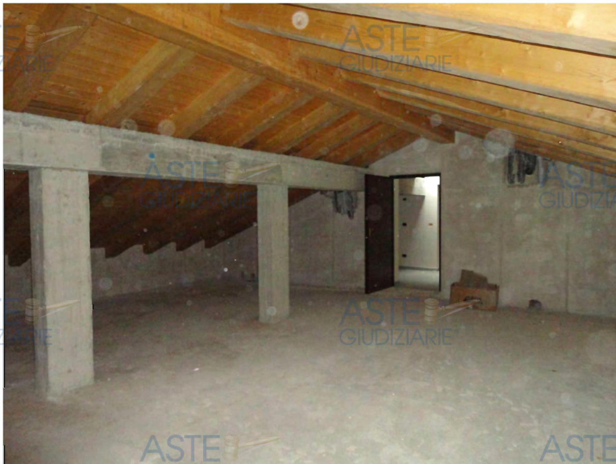
Residenza Argentera – interno sottotetto
