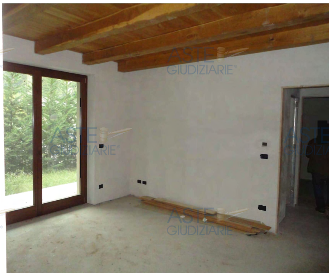
Residenza Argentera – interno alloggi
