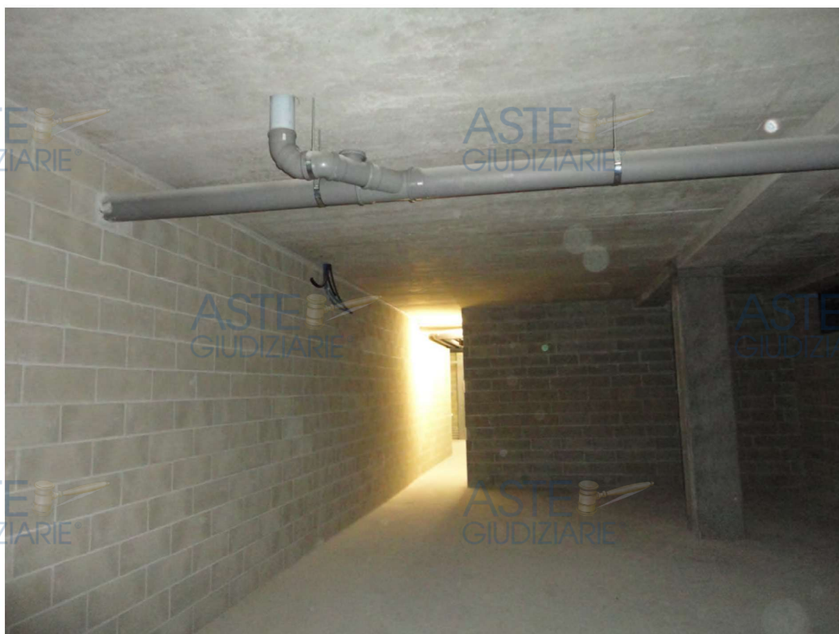
Residenza Belvedere – interno magazzino
