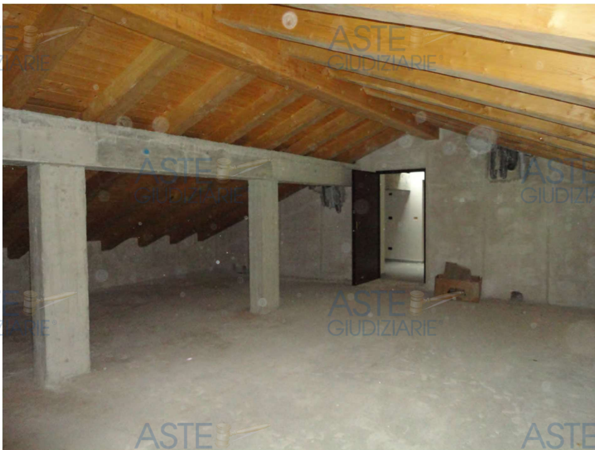
Residenza Argentera – interno sottotetto
