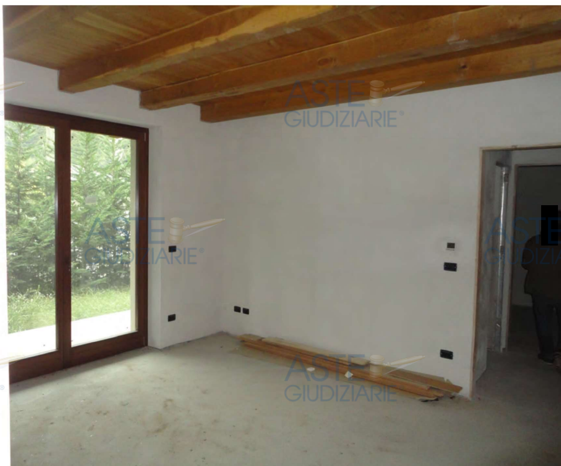
Residenza Argentera – interno alloggi
