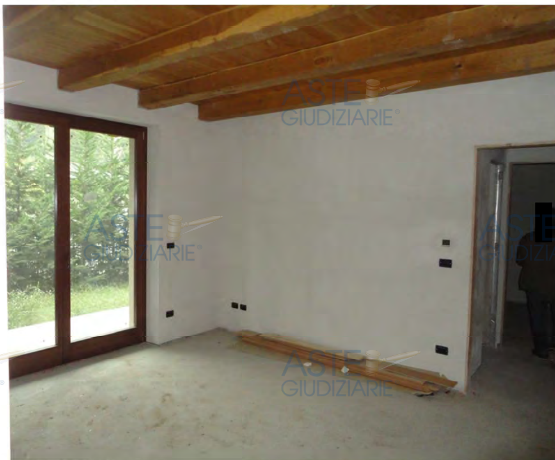
Residenza Argentera – interno alloggi
