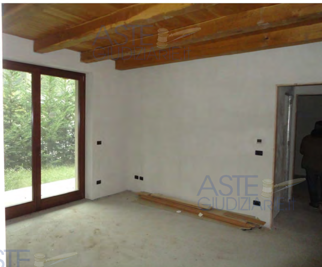
Residenza Argentera – interno alloggi
