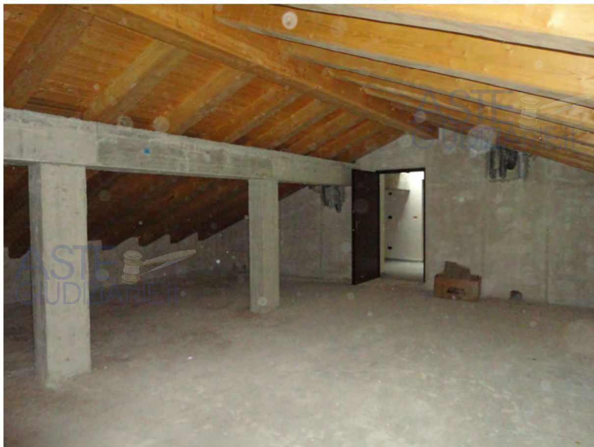
Residenza Argentera – interno sottotetto
