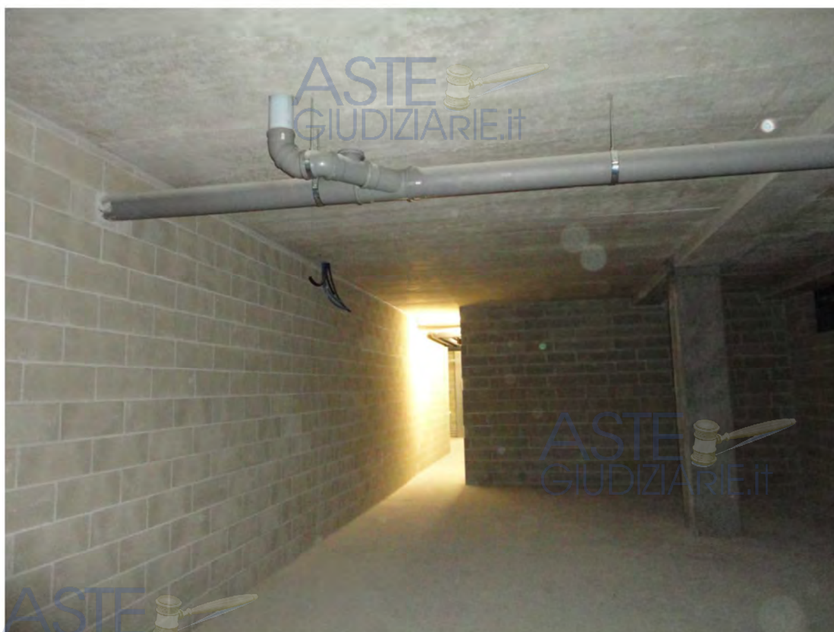
Residenza Belvedere – interno magazzino
