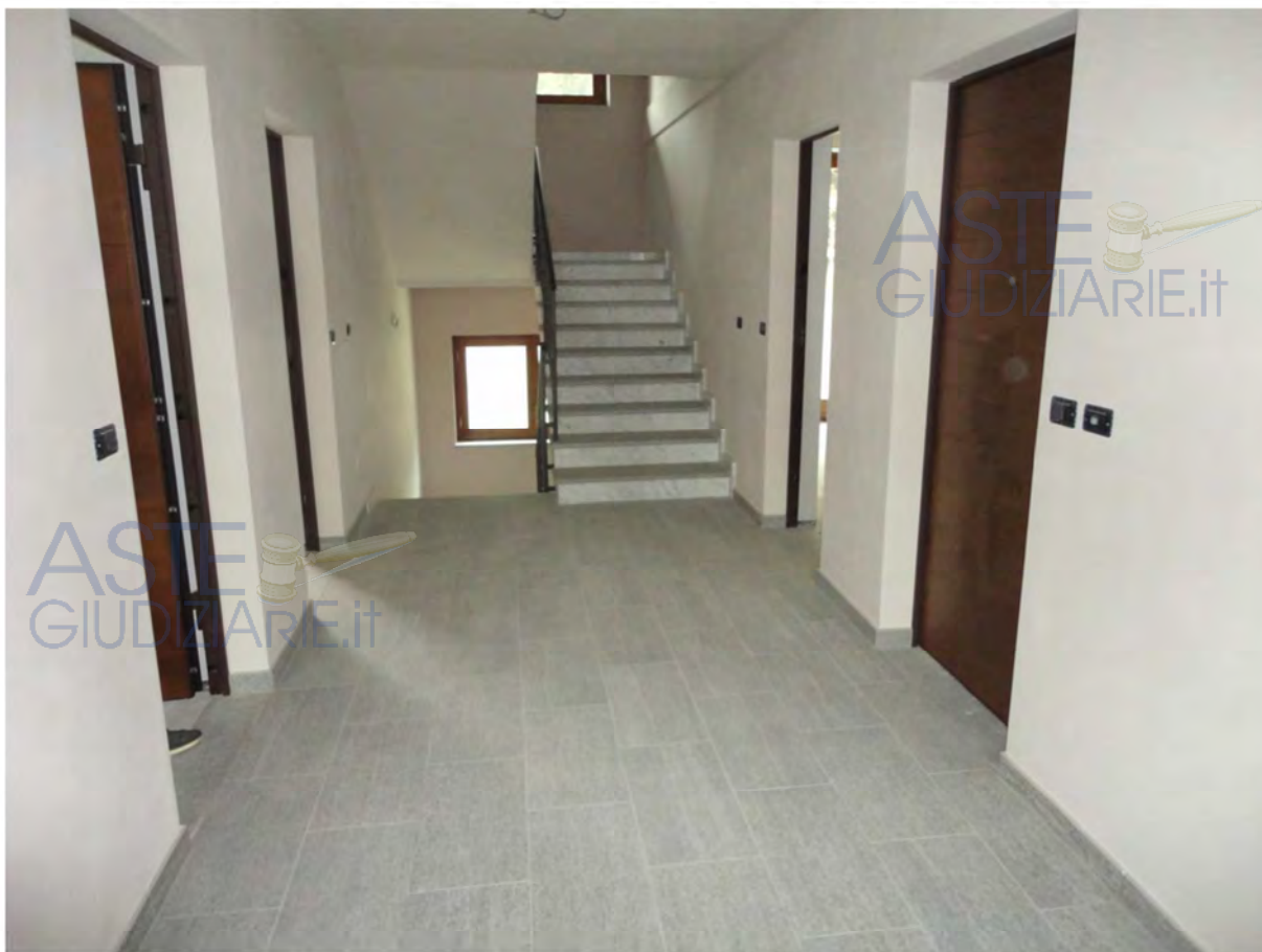
Residenza Argentera – vano scala
