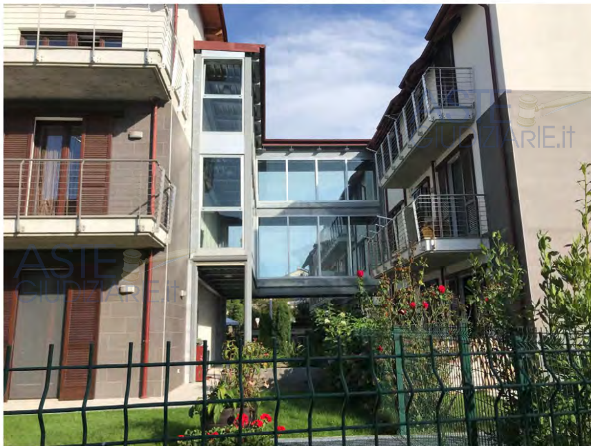
Residenza Maneggio - esterno
