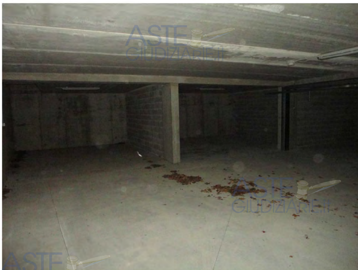
Residenza Argentera – Autorimessa
