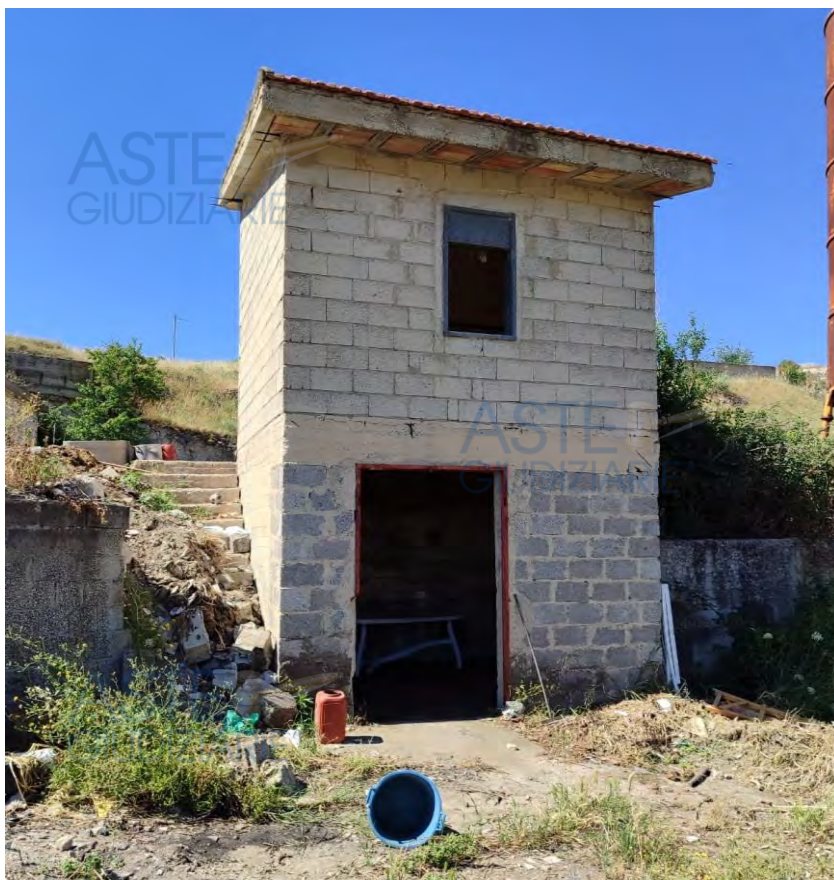
Foto n° 7 - Vista di dettaglio dell'ufficio/magazzino a servizio dell'impianto di betonaggio.
