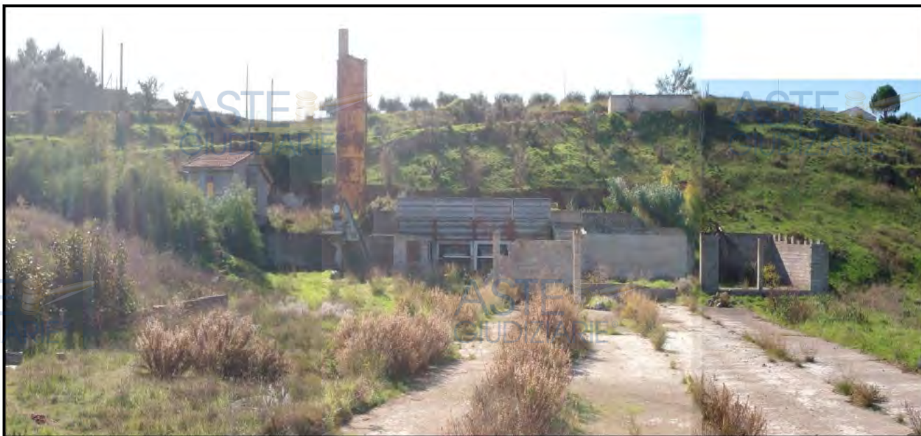
Foto n° 3 - Vista d'insieme dell'impianto di betonaggio e del piazzale a quota più bassa.
