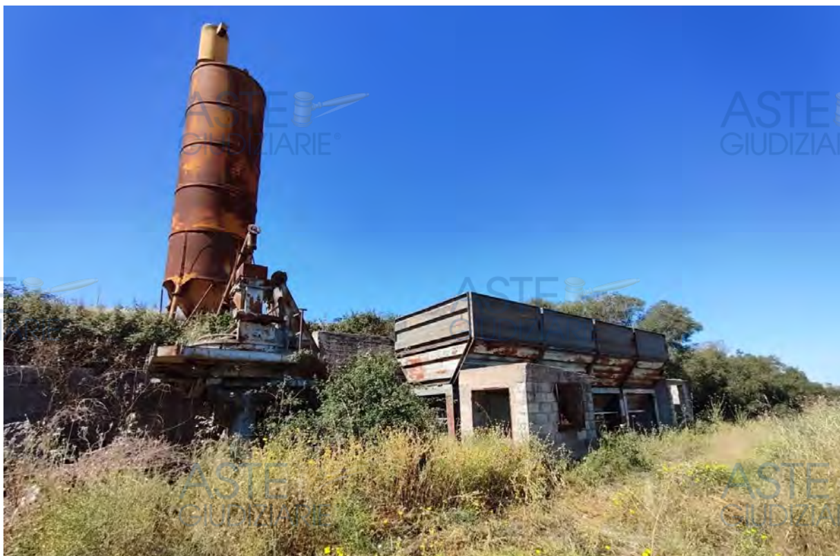
Foto n° 5 - Vista dell'impianto di betonaggio. In evidenza lo stato di abbandono.
