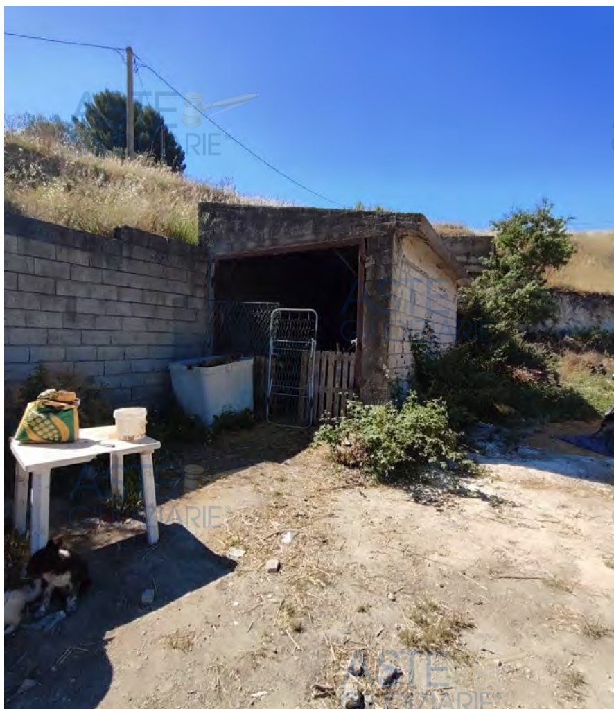
Foto n° 10 - Vista del magazzino ubicato a quota del piazzale di manovra e deposito materie prime
