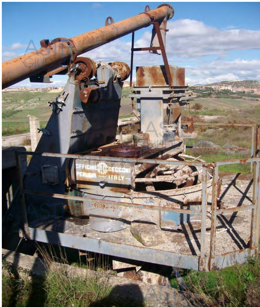
Foto n° 12 -Vista Impianto di betonaggio. In evidenza l'impastatrice.
