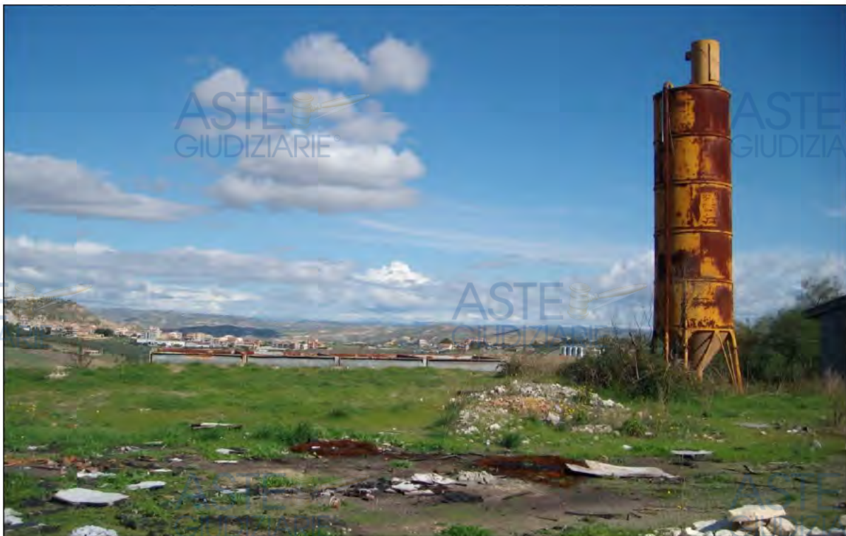
Foto n° 11 - Vista Impianto di betonaggio. In evidenza il silos verticale per lo stoccaggio del cemento
