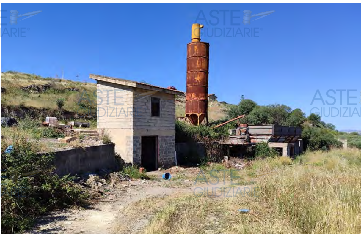
Foto n° 6 - Vista d'insieme dell'impianto di betonaggio. In evidenza la posizione dell'ufficio/magazzino.
