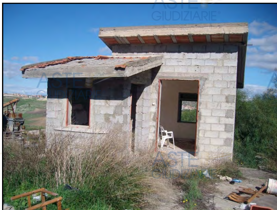
Foto n° 8 - Vista di dettaglio dell'ufficio/magazzino dal piazzale di manovra e deposito materie prime.
