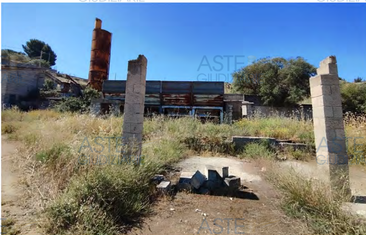
Foto n° 4 - Vista d'insieme dell'impianto di betonaggio e del piazzale a quota più bassa.
