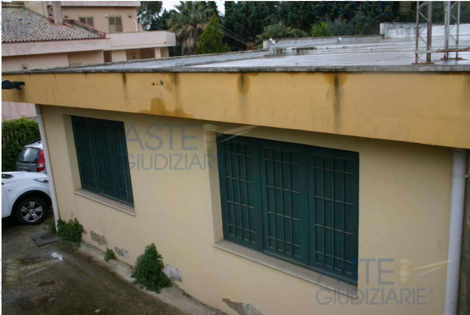
Foto 2 lotto unico fg. 90 part. 528 Via degli Ulivi 3 Caltanissetta
