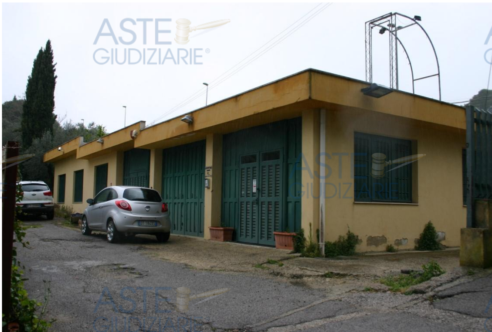
Foto 1 lotto unico fg. 90 part. 528 Via degli Ulivi 3 Caltanissetta
