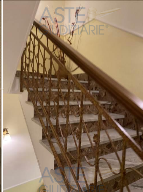
VANO SCALA CONDOMINIALE
