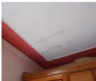
*Riscaldamento stufa a pellet e particolare della muffa sul soffitto della camera da letto*
