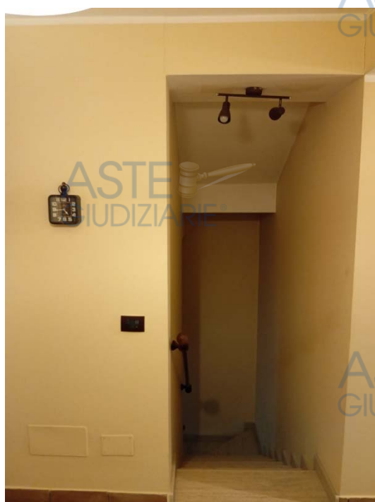
Vista scala da piano primo
