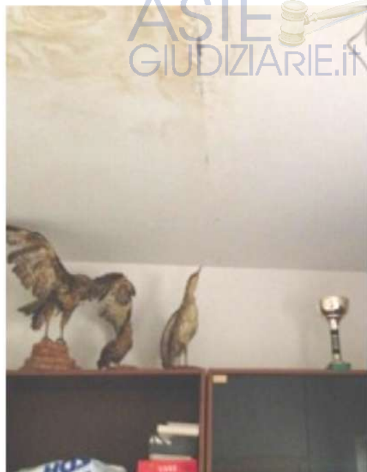
Foto 15 - Infiltrazioni (Piano 4)
