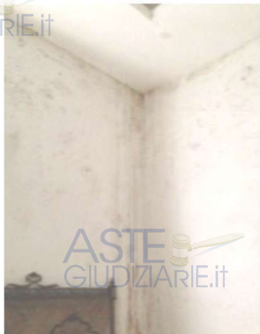
Foto 9 - Infiltrazioni (Piano 3)
