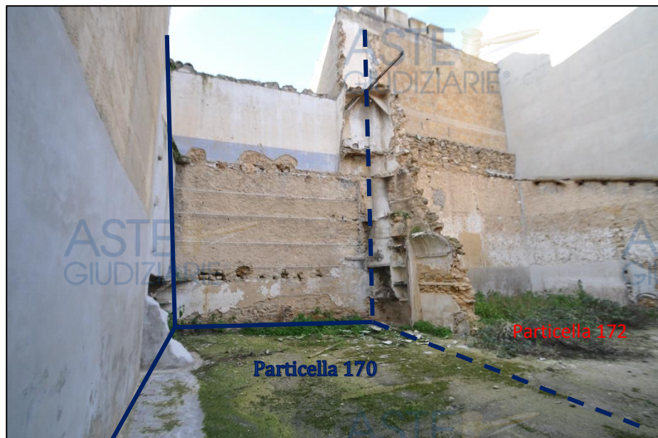
Area di sedime generata in seguito alla demolizione del fabbricato censito alla part. 170
