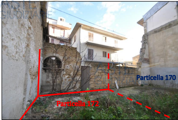
Area di sedime generata in seguito alla demolizione del fabbricato censito alla part. 172
