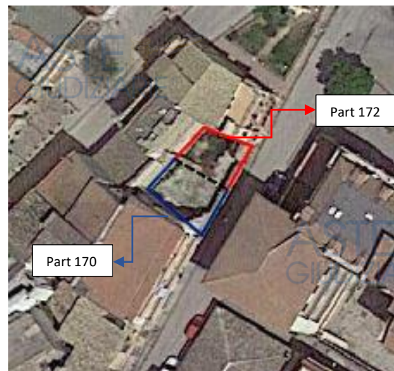
Status quo post demolizione - particelle 170-172
