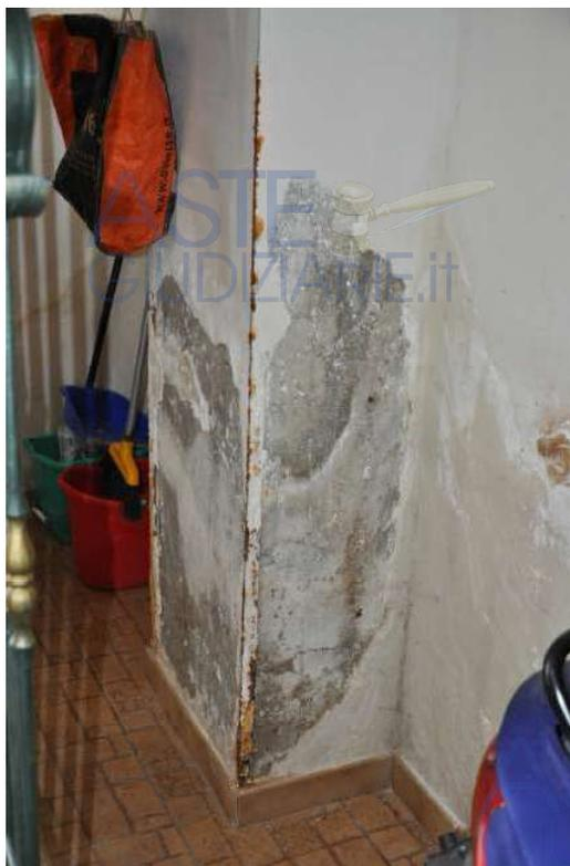
*Foto n. 18: Scrostamento di intonaco dalle pareti del box auto*
