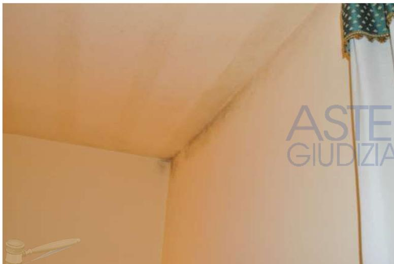
Foto n. 12: umidità e condensa presenti sul soffitto del piano primo
