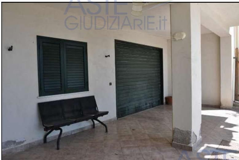
*Foto n. 20: Scrostamenti di intonaco dalle pareti esterne ai due locali di piano S1*
