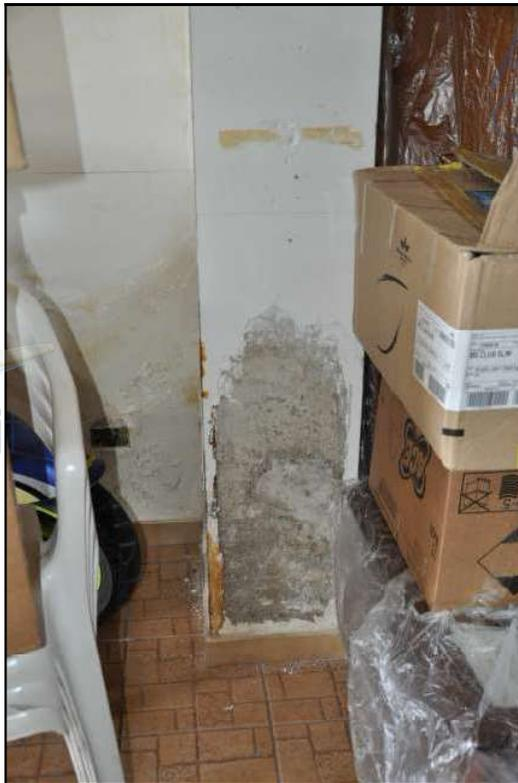
Foto n. 15: Scrostamento di intonaco dalle pareti del locale di deposito
