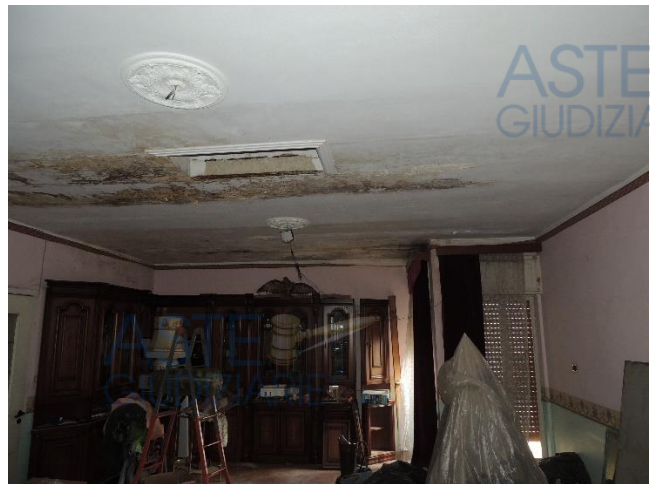
Foto n. 5 e 6 - (Solai ammalorati)
