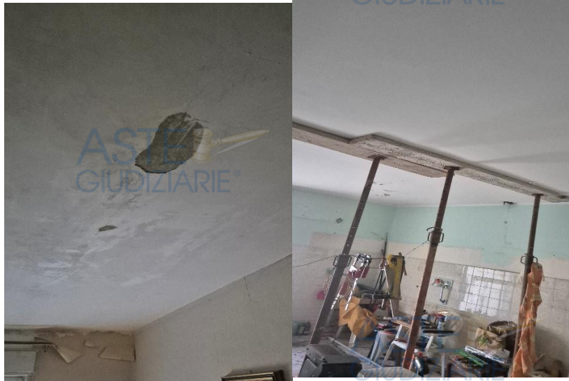
Foto n. 3 e 4 - (Solai ammalorati e puntellati)
