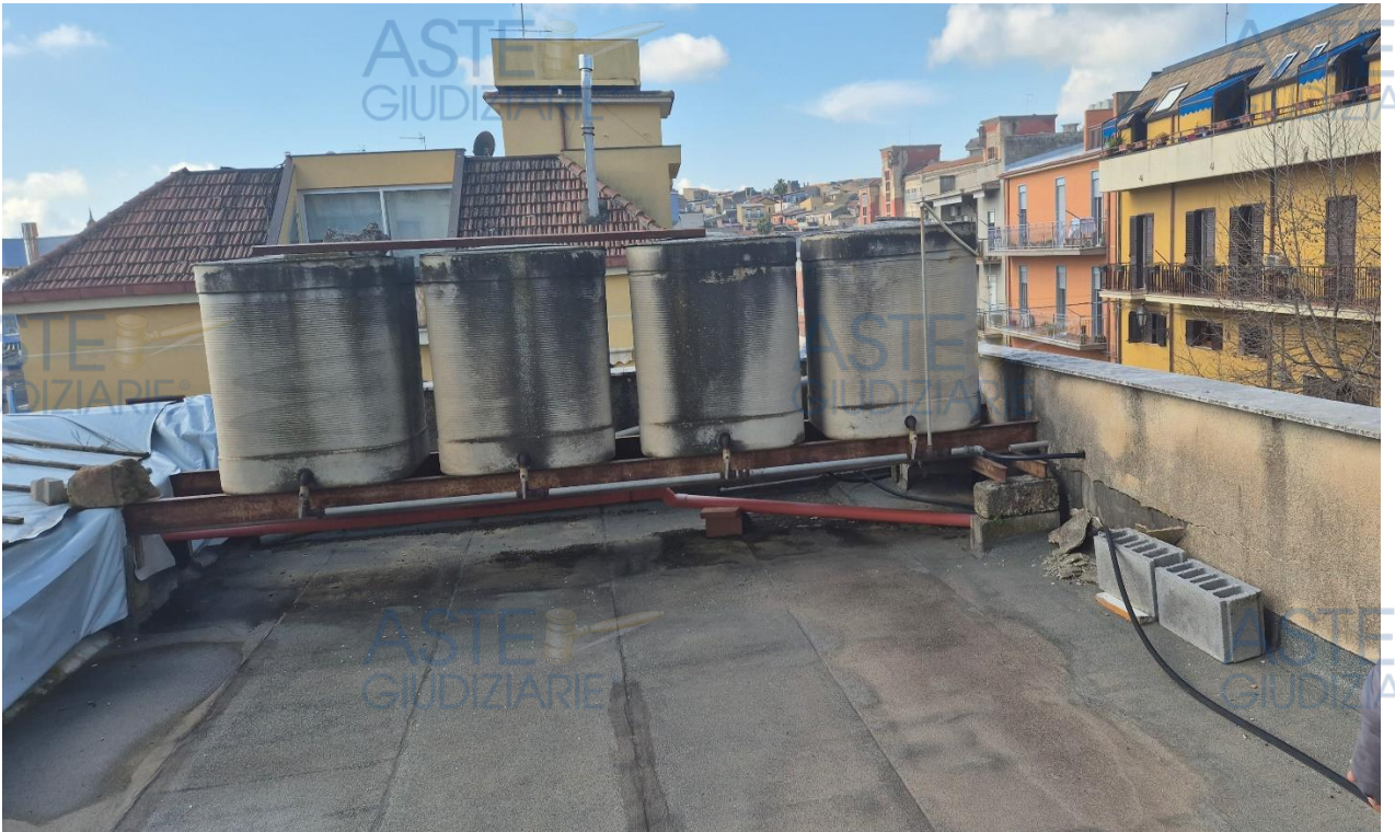
Foto n. 1 e 2 - (Terrazzo di copertura)
