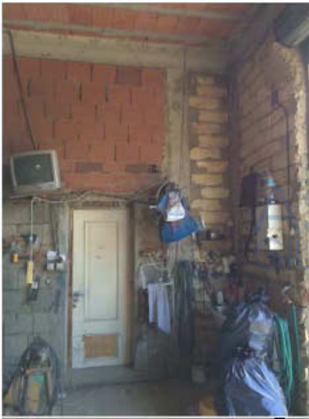
Foto interne immobile (garage)
