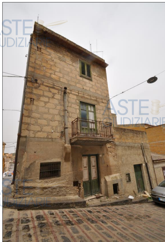
Ingresso dalla via Silvio Pellico
