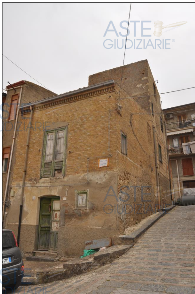
Ingresso Via Dante Alighieri n.22
