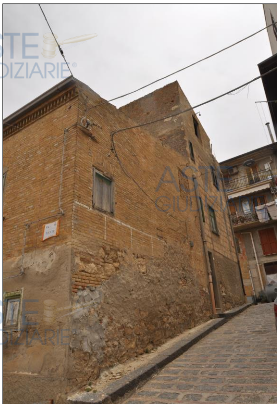
Ingresso dalla via Nicolò Audino n.1
