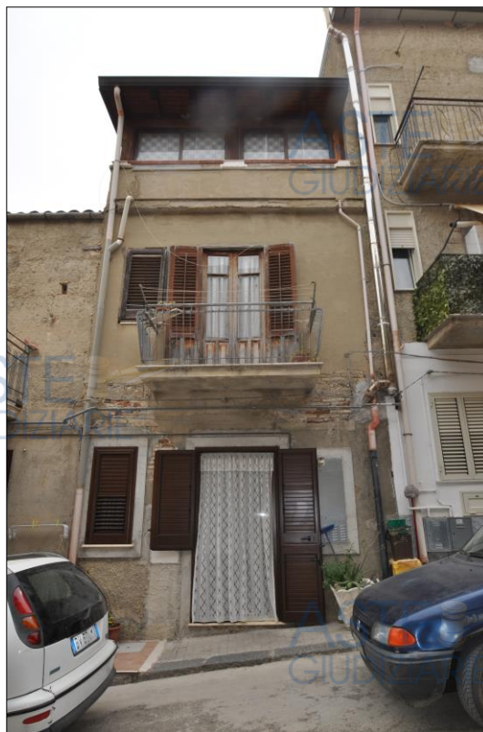
Ingresso via Vincenzo Florio
