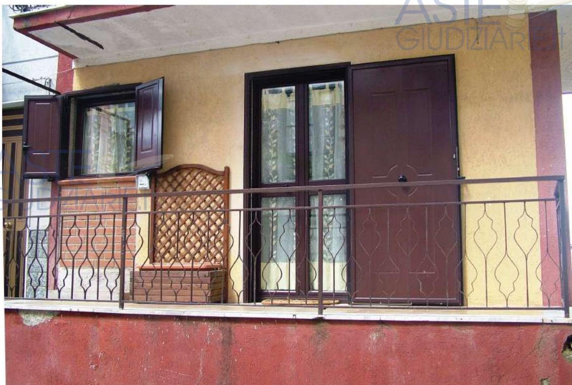
FOTO 3 Ingresso principale Via Marino Mistretta, n.22
