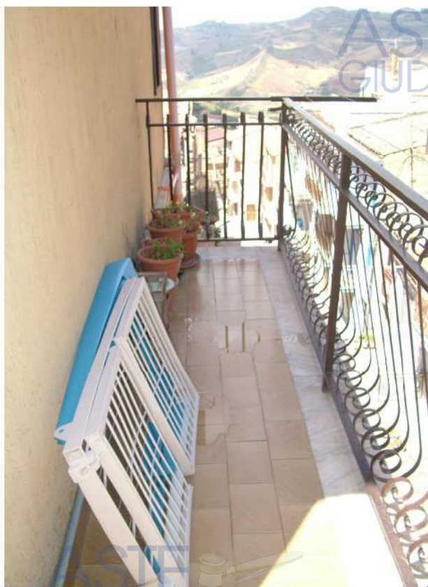
FOTO 16 Balcone piano 1° vista su via Marconi
