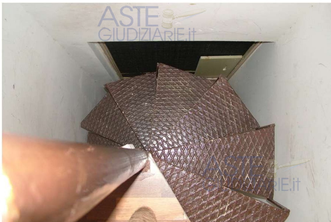
FOTO 8 Vano al piano terra Scala a chiocciola per accesso al vano sottostante
