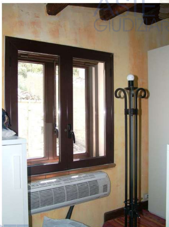
FOTO 23 Vano sotto tetto
