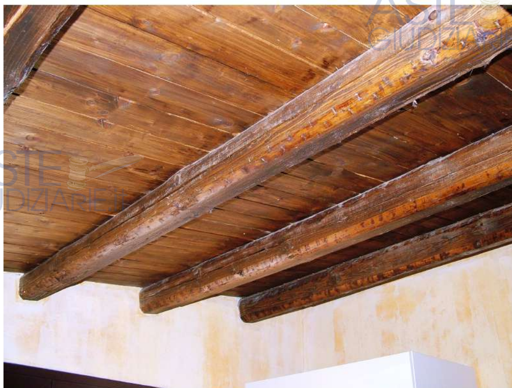
FOTO 23 Particolare tetto spiovente vano sotto tetto
