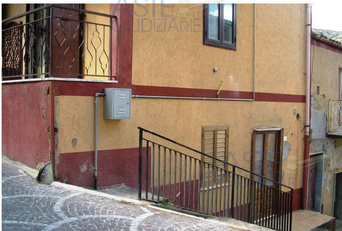
FOTO 4 Accesso al vano deposito da Via Marconi
